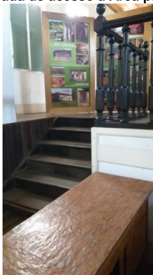
Figura 7 – Escada de acesso à Área para Exposições
