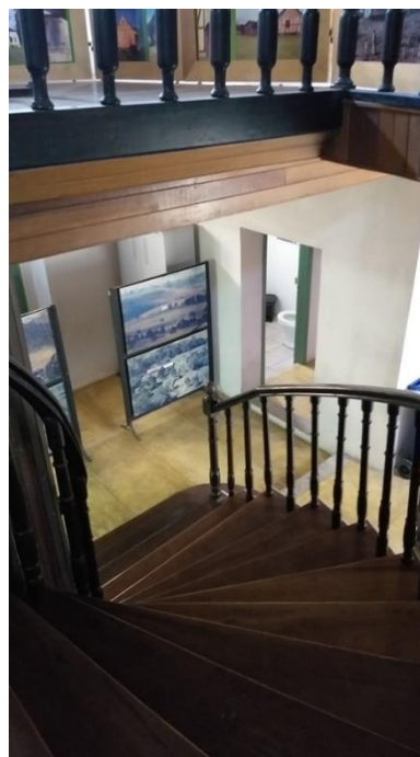
Figura 10 – Escada Interna – Vista do Pavimento Superior
