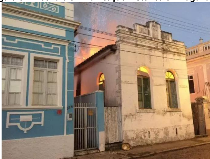
Figura 3 – Incêndio em Edificação histórica em Laguna/SC
