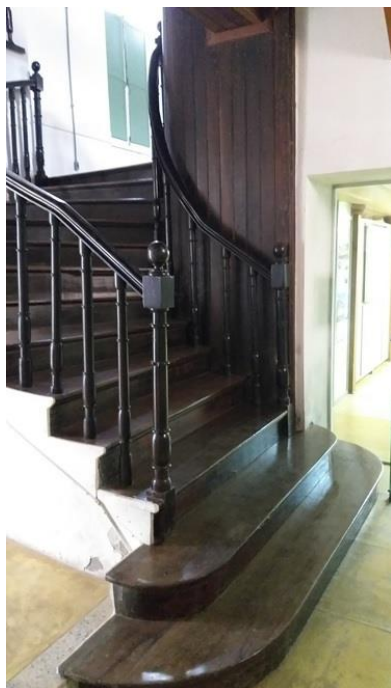
Figura 9 – Escada Interna – Acesso ao Pavimento Superior – Vista do Pavimento Térreo
