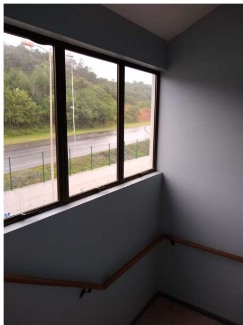
Figura 29 – Janela escada protegida
