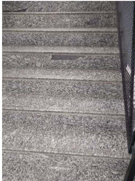
Figura 34 – Piso escada comum
