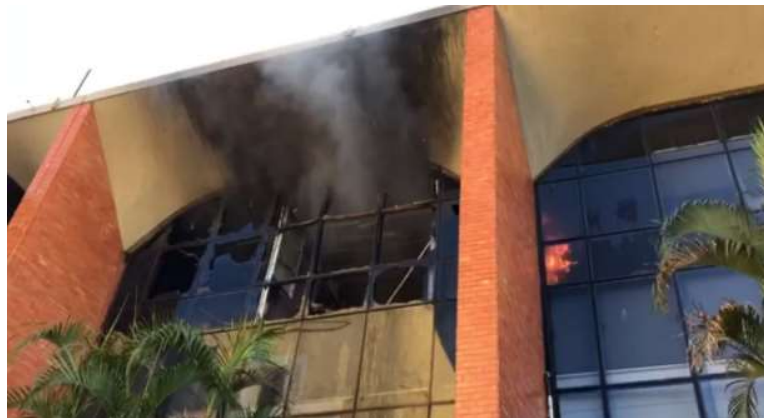
Figura 1 - Incêndio no piso superior do Tribunal de Justiça do Tocantins
