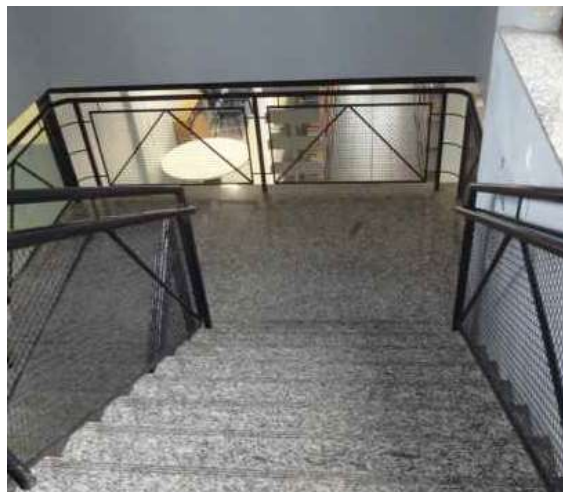
Figura 27 – Escada de acesso ao pavimento ático
