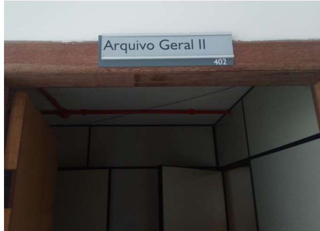
Figura 36 – Compartimentação por divisória leve
