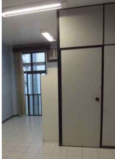
Figura 41 – Exemplo compartimentação interna em divisória leve
