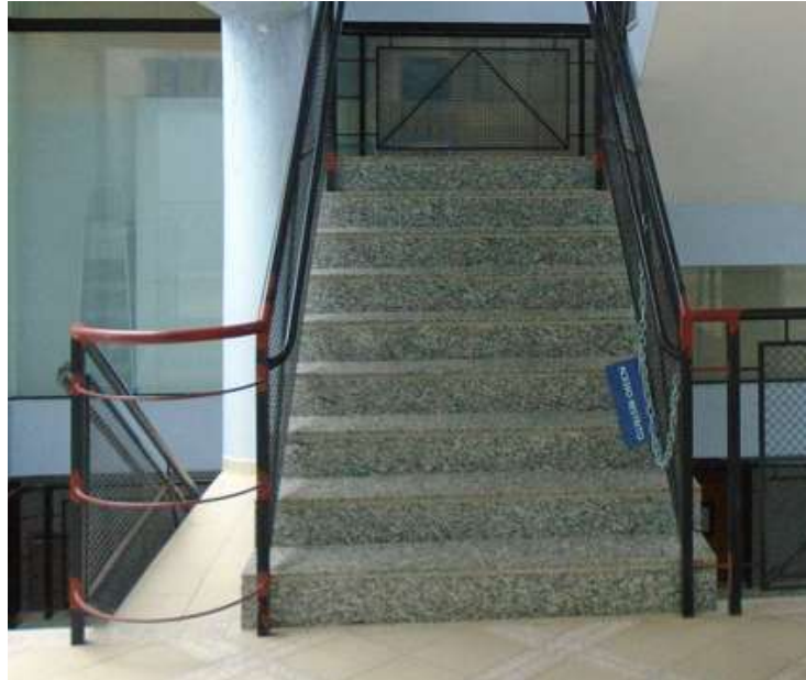
Figura 30 – Guarda-corpo e corrimão
