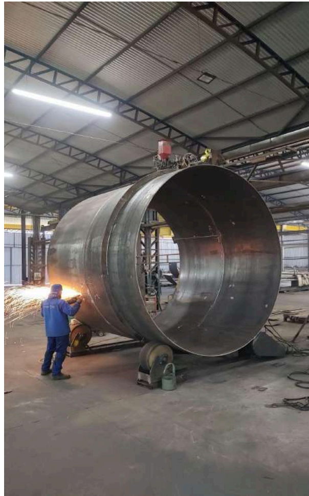
Figura 1 - Trecho reto do Conduto Forçado
