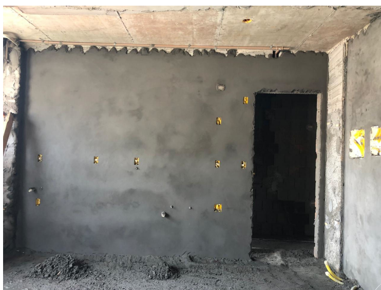
Figura 22 – Reboco desempenado
