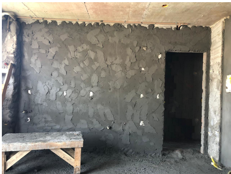
Figura 21 – Reboco após retirar o excesso
