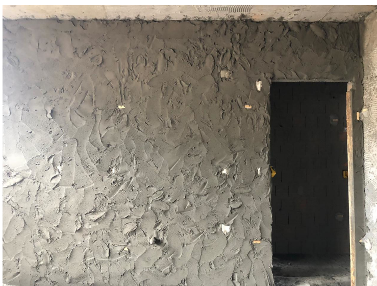
Figura 20 – Reboco após aplicação
