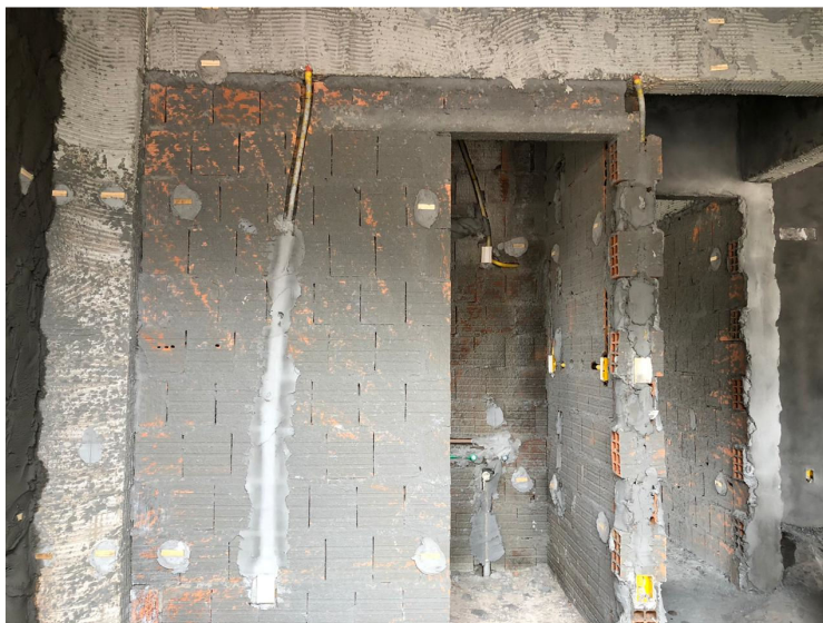
Figura 19 - Execução de chapisco
