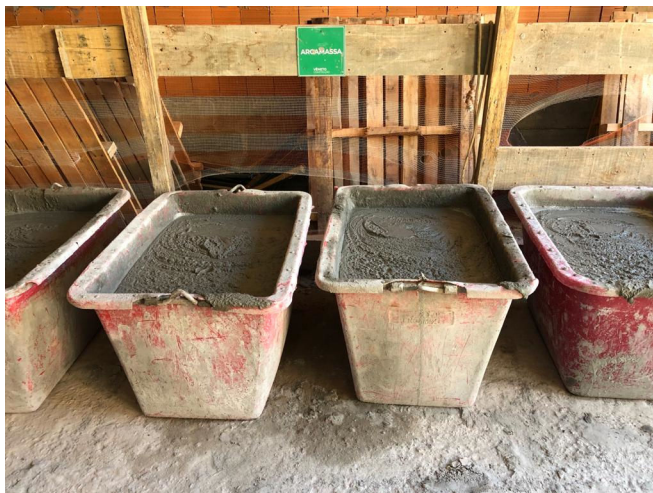
Figura 11 - Armazenamento da argamassa
