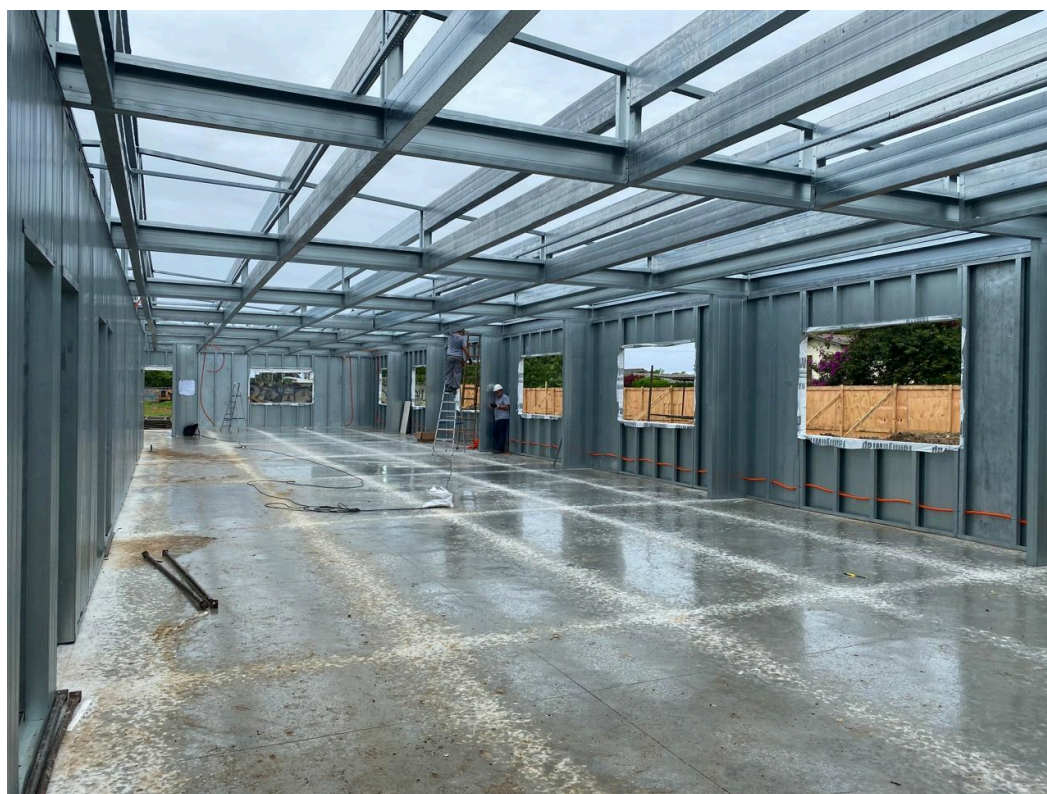
Foto 4 - Execução da Edificação, Painéis.
