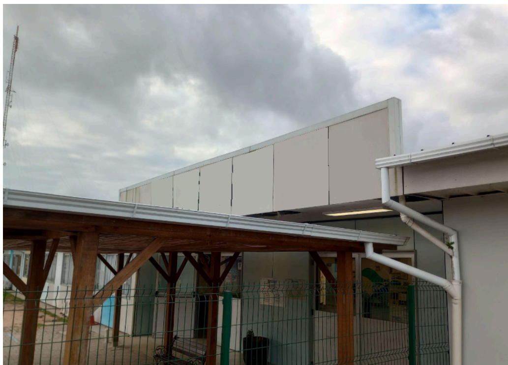
Foto 1 - Fachada Frontal da Edificação (foto tratada).
