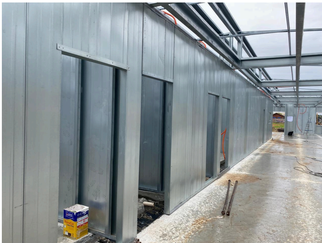
Foto 6 - Execução da Edificação, Aberturas.
