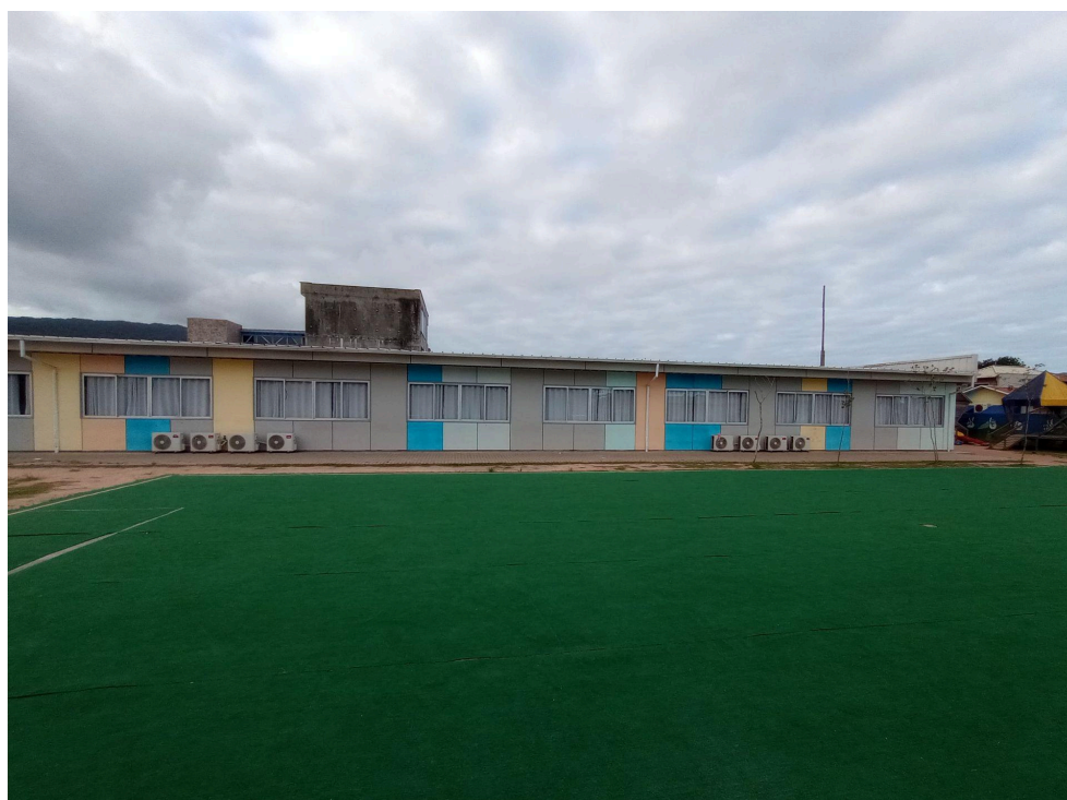
Foto 3 - Pátio da Edificação.
