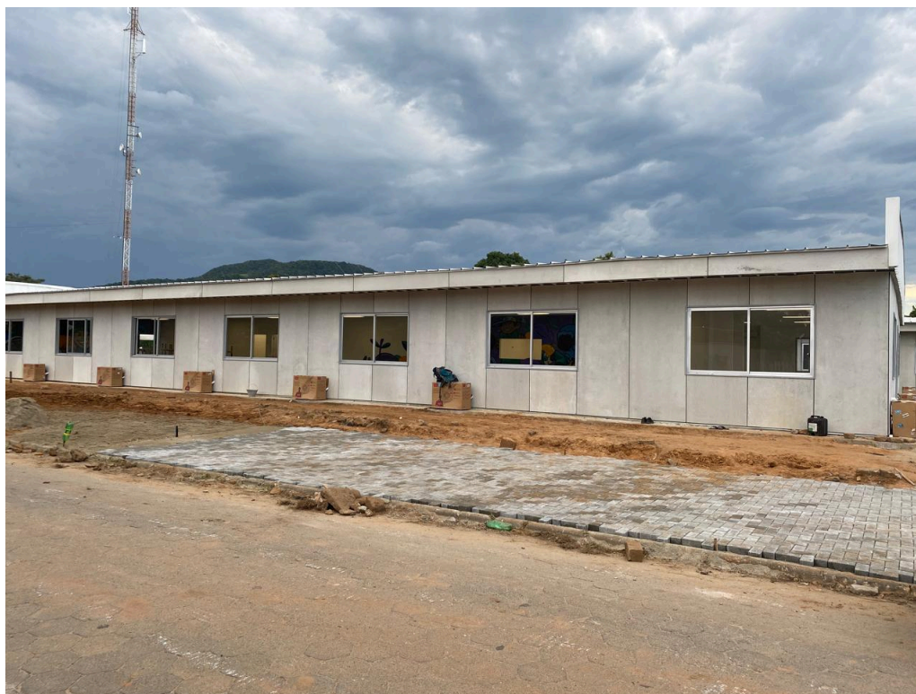
Foto 7 - Execução da Edificação, Esquadrias.
