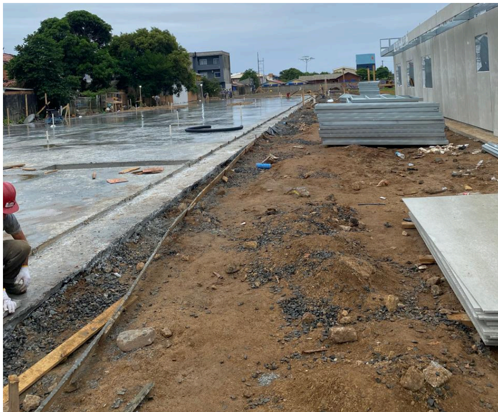
Foto 5 - Execução da Edificação, Pátio.
