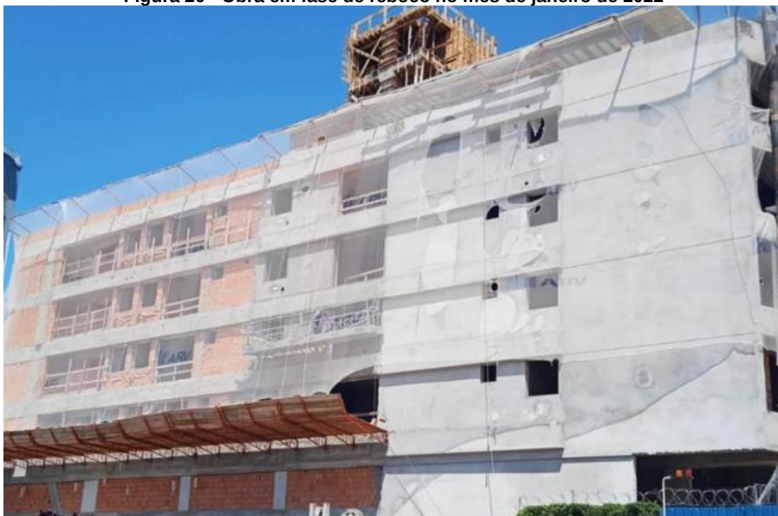
Figura 20 - Obra em fase de reboco no mês de janeiro de 2022
