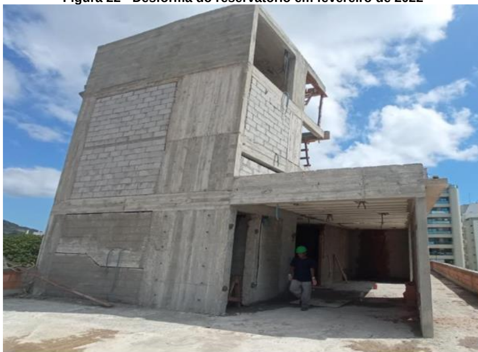
Figura 22 - Desforma do reservatório em fevereiro de 2022
