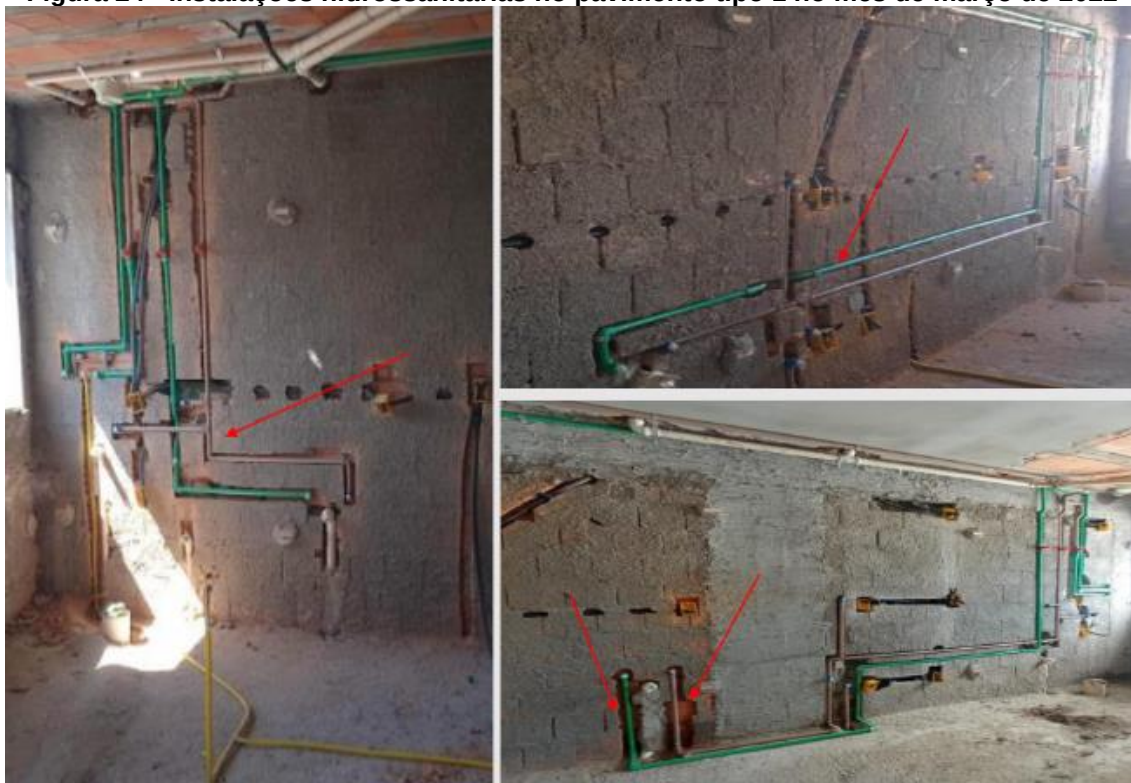
Figura 24 - Instalações hidrossanitárias no pavimento tipo 1 no mês de março de 2022
