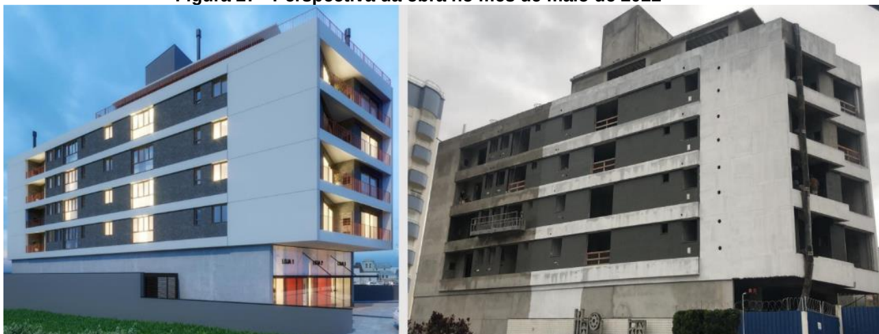
Figura 27 - Perspectiva da obra no mês de maio de 2022
