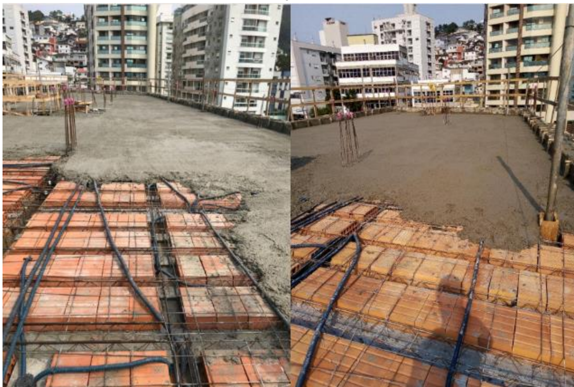
Figura 17 - Lançamento e adensamento de concreto estrutural pavimento TIPO 4 em julho de 2021
