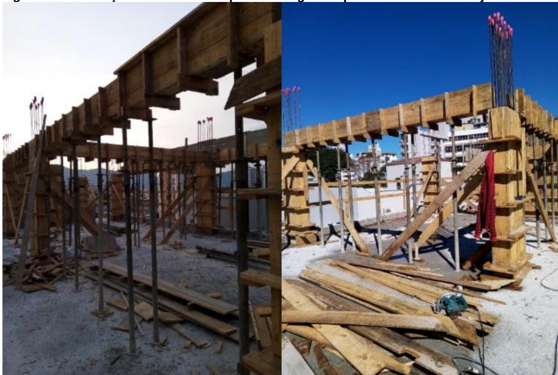
Figura 16 - Execução das formas de pilares e vigas do pavimento TIPO 3 em julho de 2021
