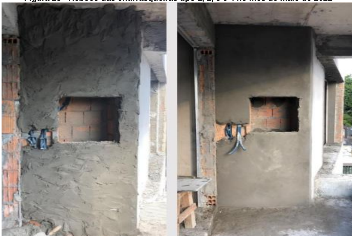
Figura 28 - Reboco das churrasqueiras tipo 1, 2, 3 e 4 no mês de maio de 2022
