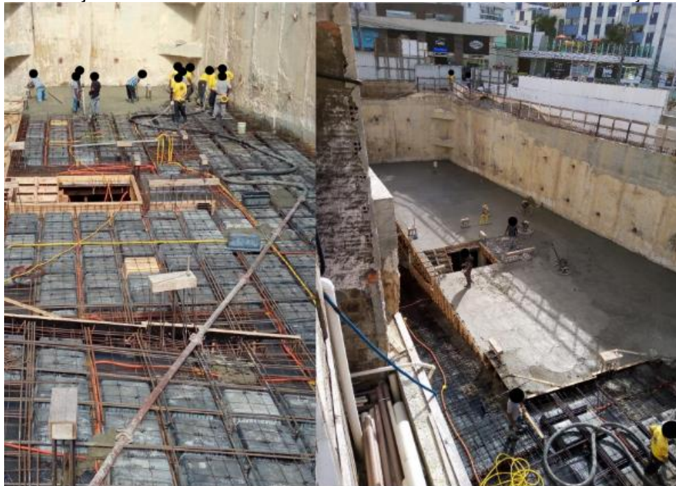
Figura 9 - Lançamento e adensamento de concreto da estrutura SS02 em março de 2021
