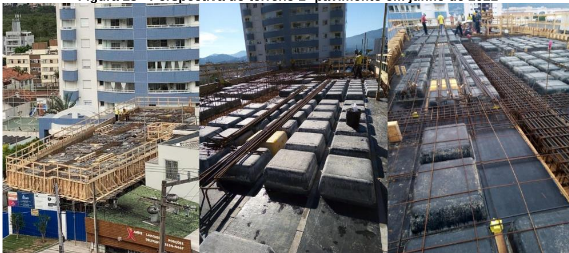
Figura 13 - Perspectiva do terreno 2º pavimento em junho de 2021
