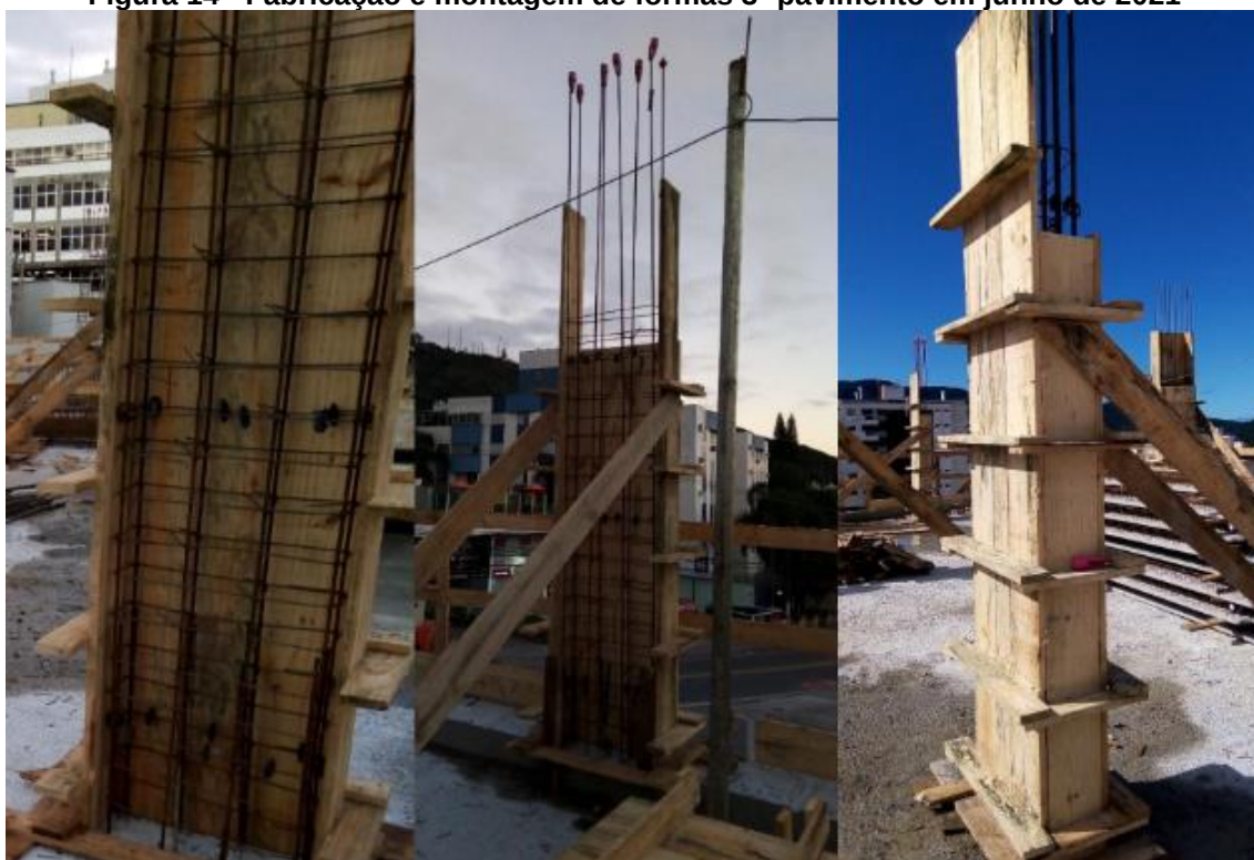
Figura 14 - Fabricação e montagem de formas 3º pavimento em junho de 2021
