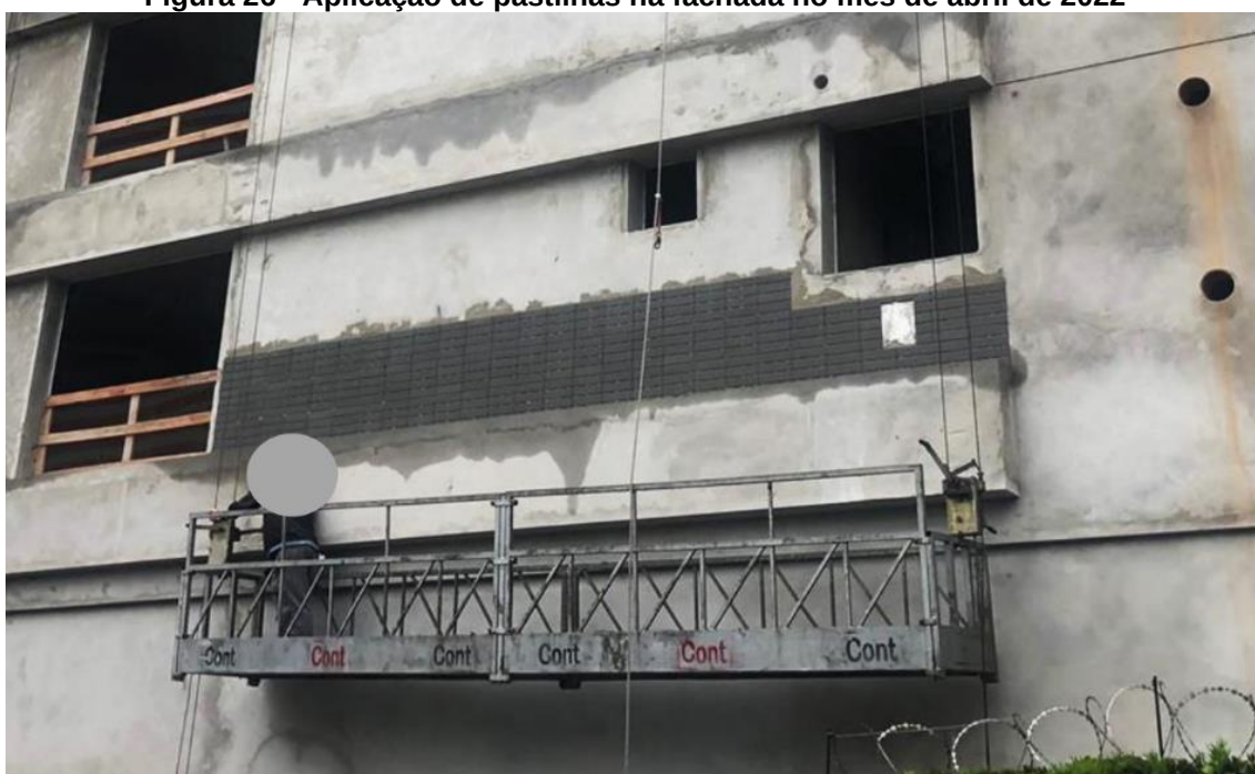
Figura 26 - Aplicação de pastilhas na fachada no mês de abril de 2022
