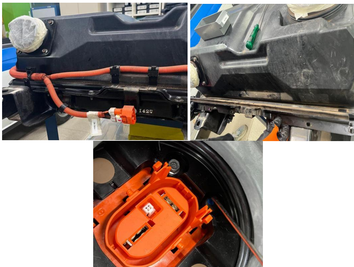
Figura 13 – Remoção dos cabos e barras laterais da carcaça
