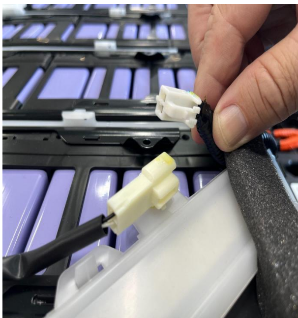
Figura 18 – Módulos de monitoramento, conectores e chicotes de comunicação
