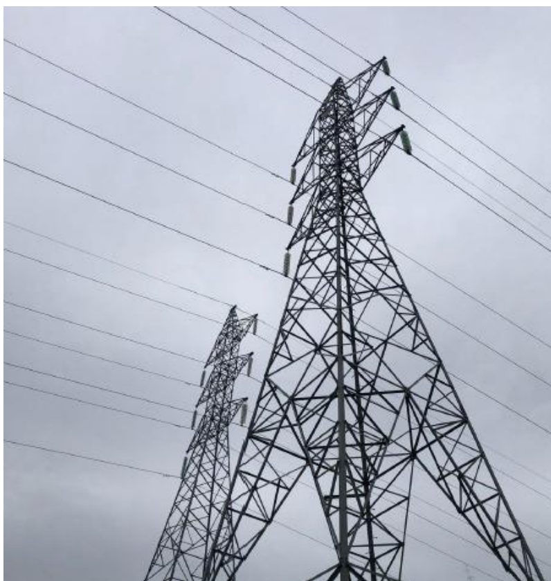
Figura 3 - Torre de suspensão LT 138 kV
