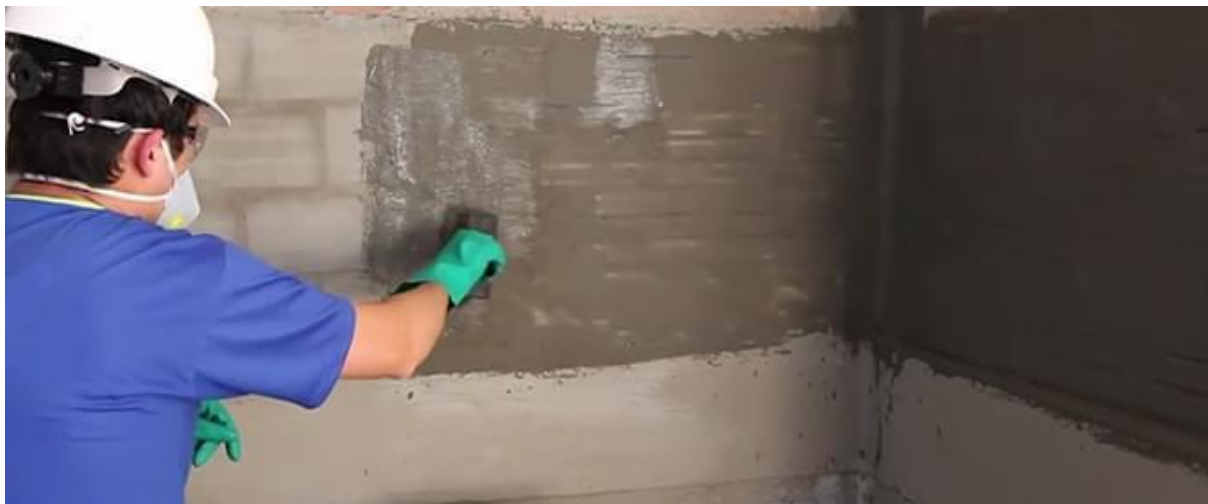
Figura 11 – Impermeabilização de paredes enterradas.
