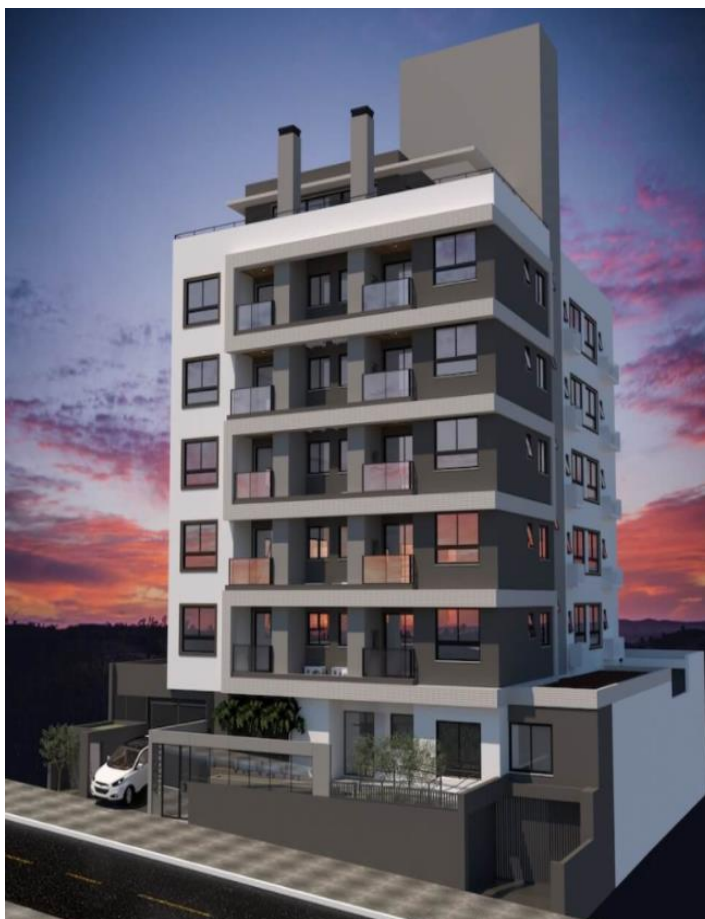
Figura 14 – Imagem da obra onde foi realizado o estudo de caso após finalizada
