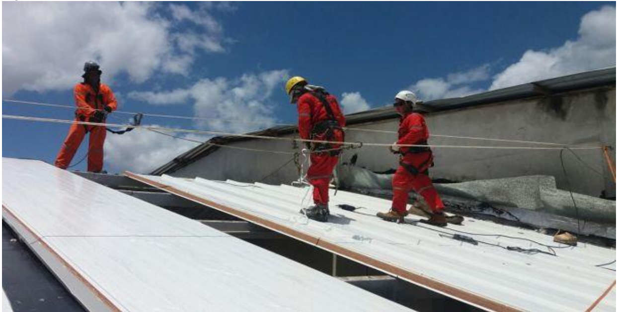
Figura 2: Trabalho em telhado
