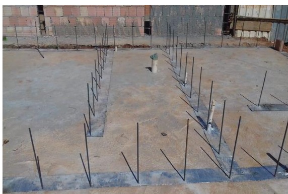
Figura 2 – Arranques numa fundação de radier
