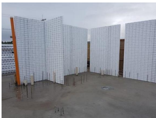
Figura 4 – Painéis posicionados conforme os arranques
