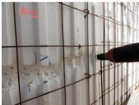
Figura 5 - Preparação dos painéis para a passagem de tubulações
