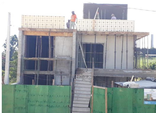
Figura 12 – Obra em andamento em Vinhedo - SP
