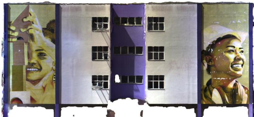
Figura 3. Ortomosaico da Fachada Oeste.
