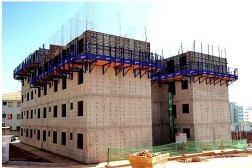
Figura 1 - Obra com o sistema de paredes de concreto moldada no local
