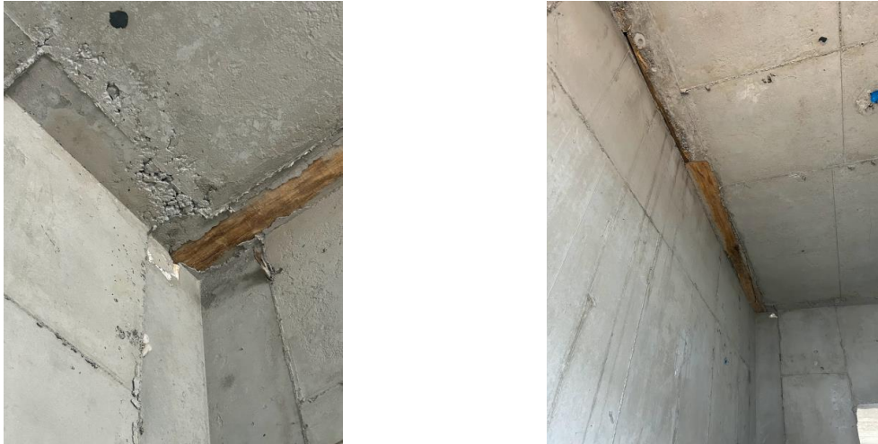
Figura 34 - Utilização de madeira para vedação das fôrmas
