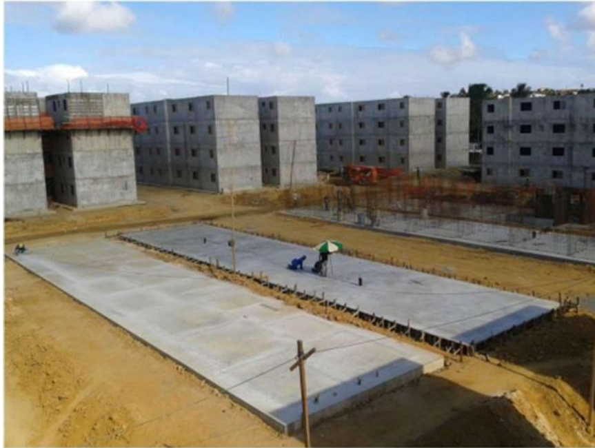
Figura 2 - Fundação em radier
