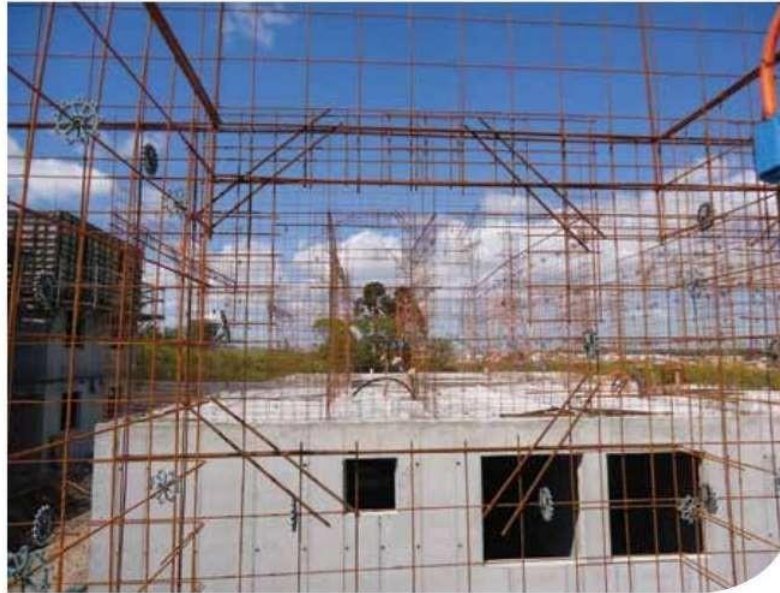
Figura 4 - Reforço de armadura nos cantos
