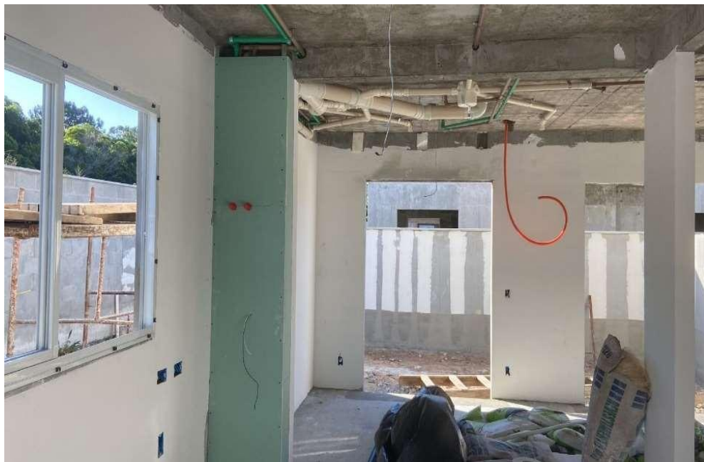
Figura 28 - Rede hidráulica vertical e horizontal
