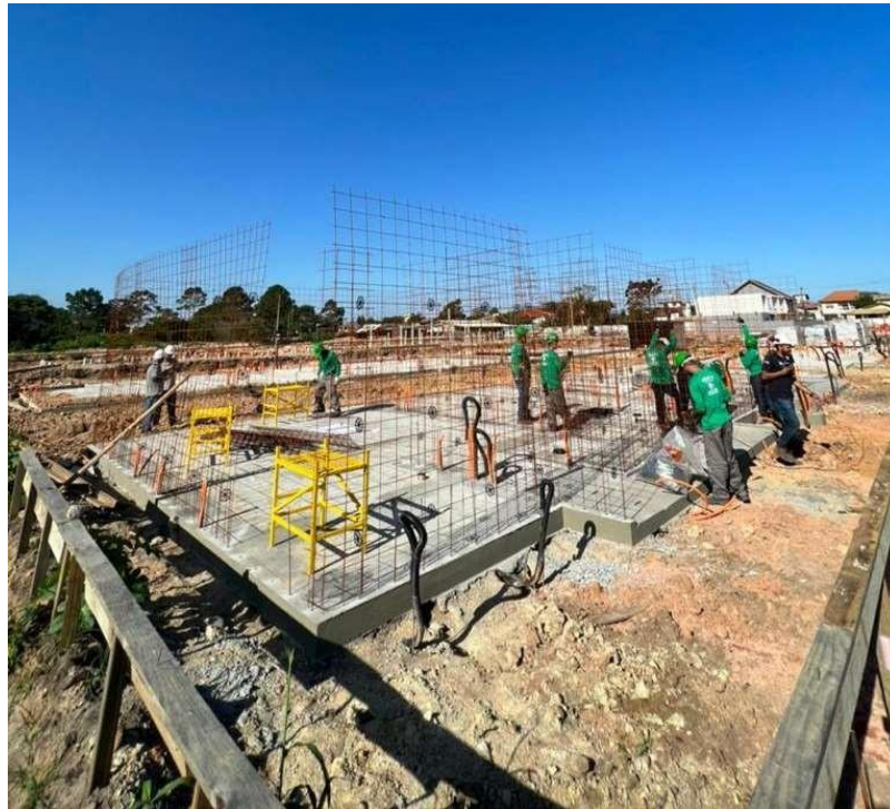
Figura 24 - Armação com tela soldável
