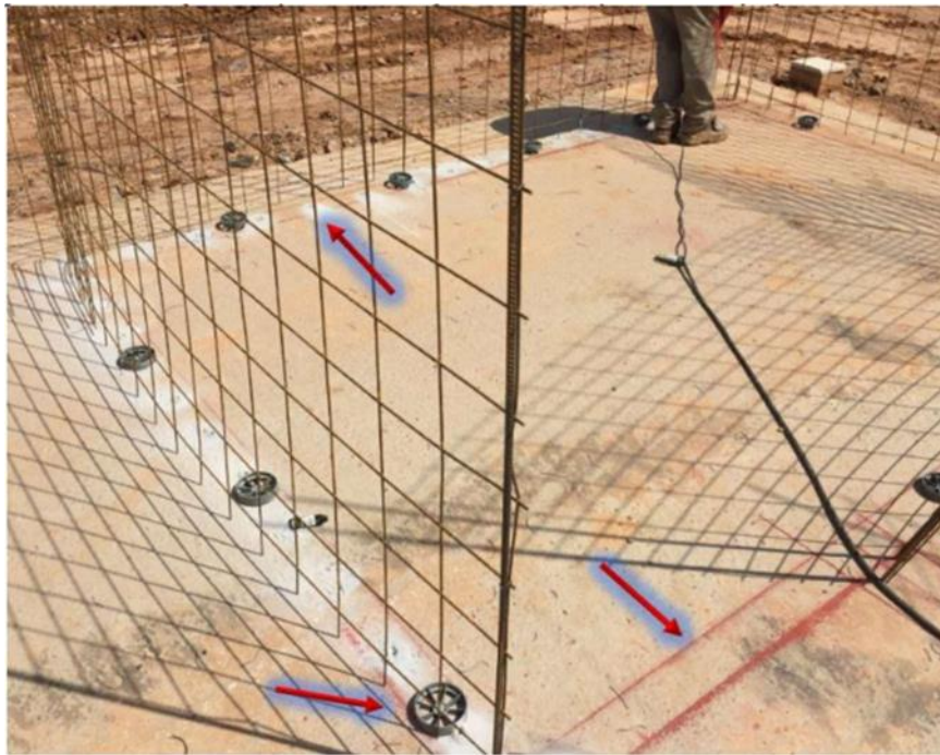
Figura 5 - Espaçadores e a tela de armação
