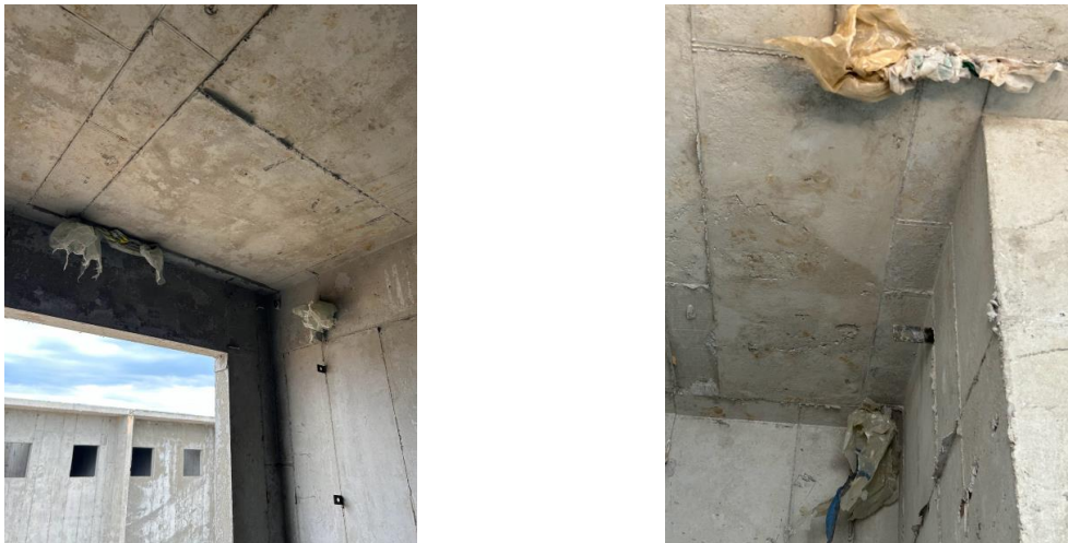
Figura 35 – Uso de polímero para fechamento das fôrmas
