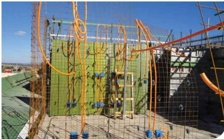
Figura 6 - Caixas e eletrodutos presos na armadura
