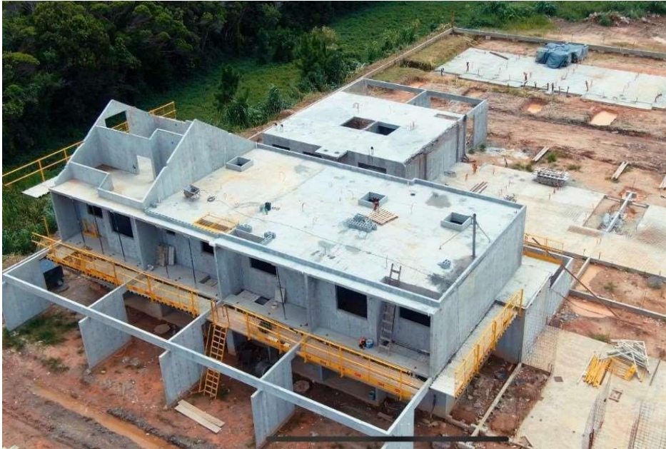
Figura 10 - Casas concretadas com a utilização das fôrmas
