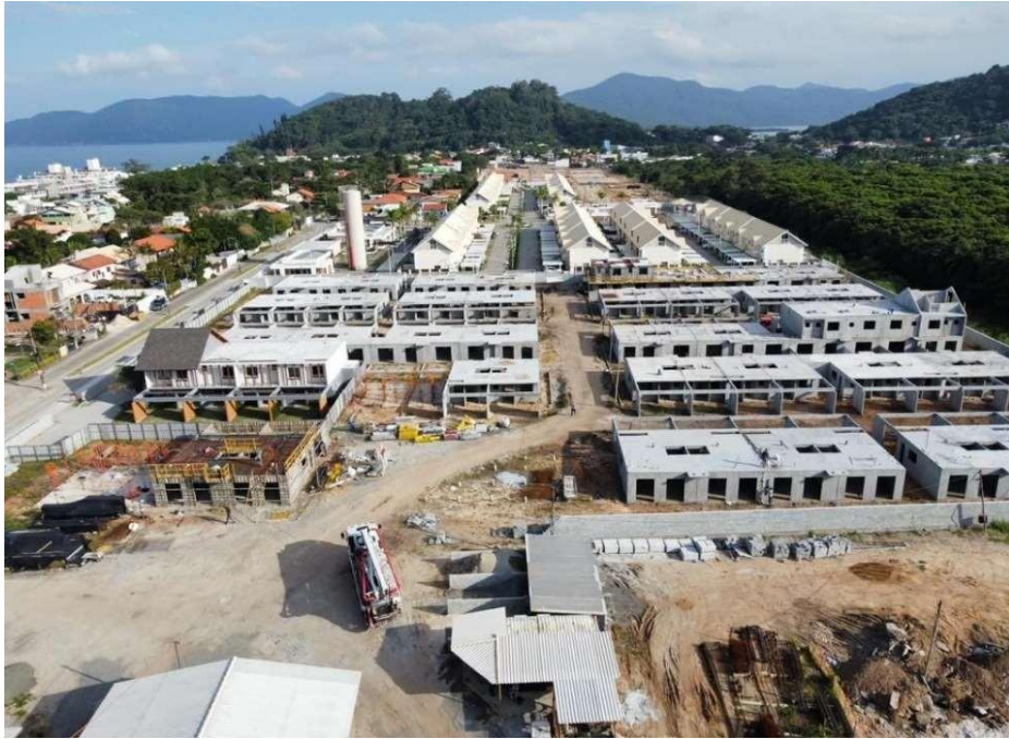
Figura 12 – Foto aérea do empreendimento
