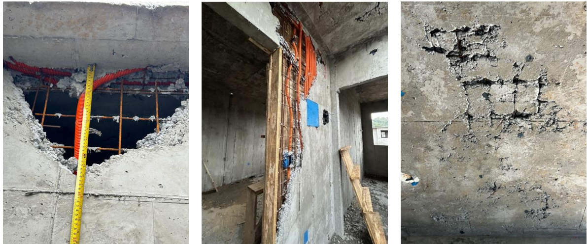
Figura 39 - Armadura exposta
