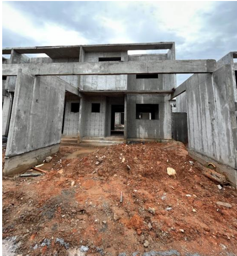
Figura 23 – Fundação externa à edificação.
