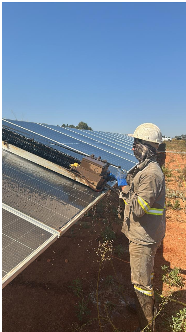
Figura 1 – Mantenedor limpando os módulos.
