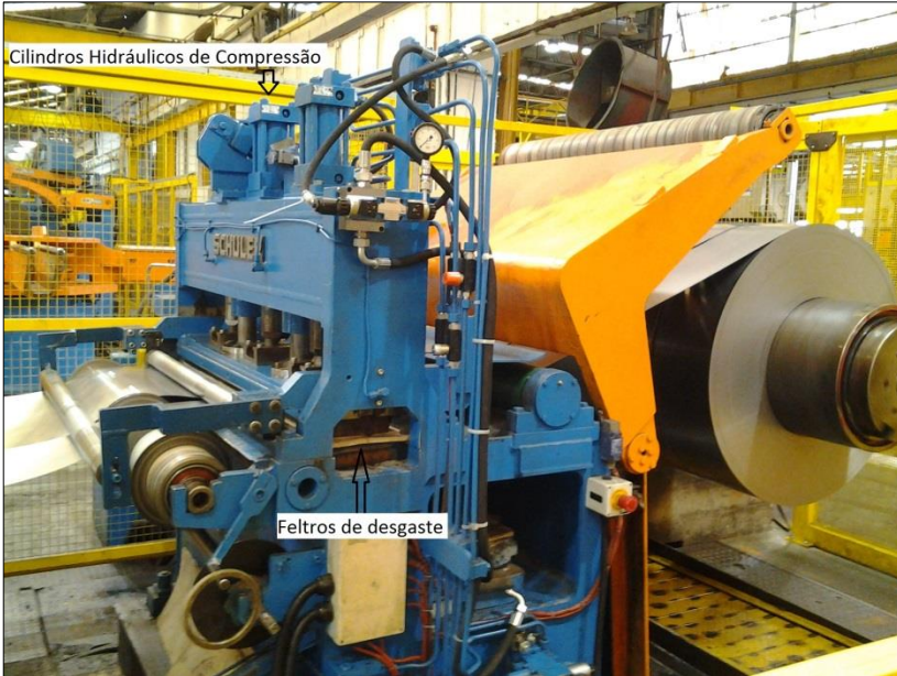
Figura 46 - Sistema de Tensionamento com Acionamento Hidráulico Fonte: (AUTOR 2013)
