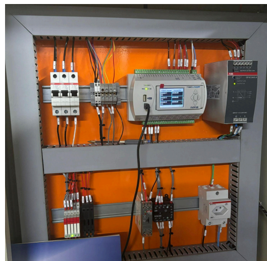
Figura 19:(A) Detectores de amônia e (B) central de controle de detectores.
