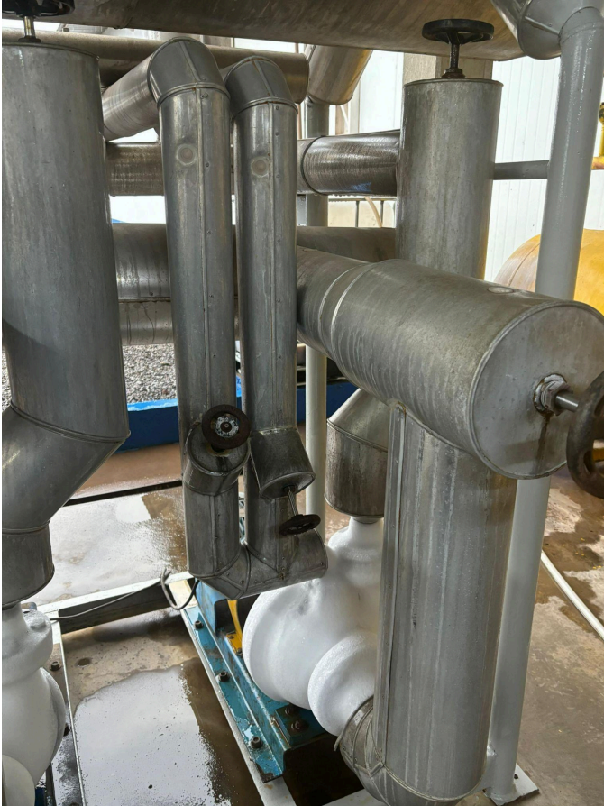
Figura 23. Isolamento das tubulações.
