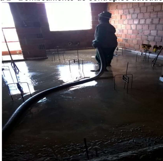
Figura 2 - Bombeamento de contrapiso autoadensável
