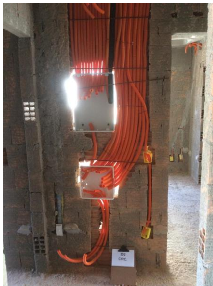
Figura 24 - Quadro durante a obra
