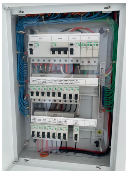
Figura 25 - Quadro após a obra
