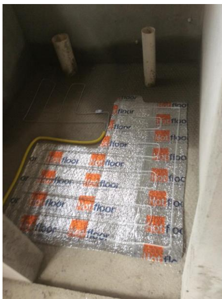
Figura 27 - Instalação de pisos aquecidos
