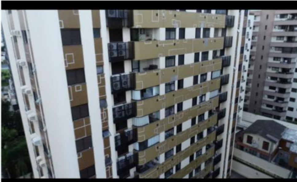
Figura 32- Registro através de drone na inspeção da fachada Oeste
