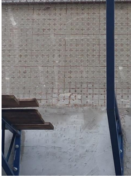
Figura 28- Cordões não foram desfeitos
