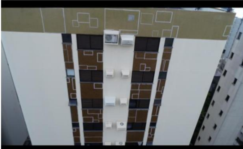
Figura 30- Registro através de drone na inspeção da fachada Sul
