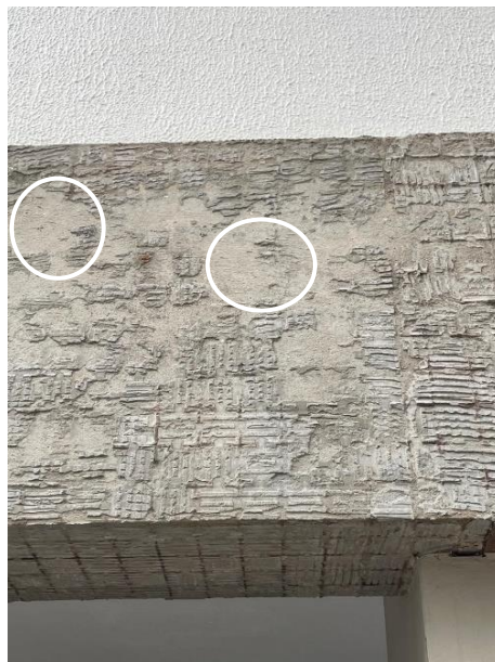
Figura 25- Emboço aparente
