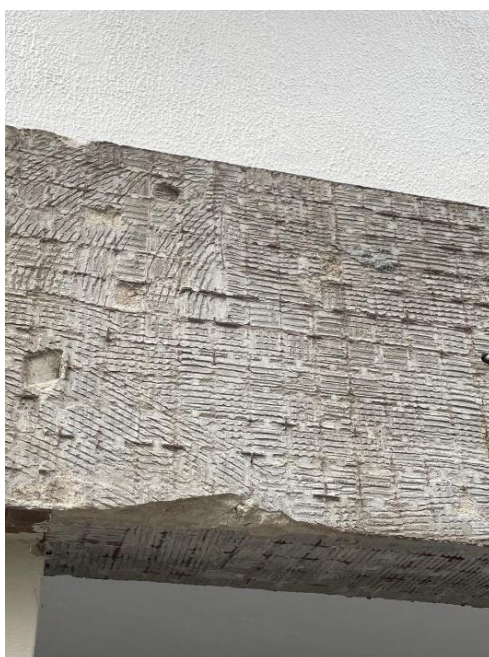
Figura 27- Cordões não foram desfeitos
