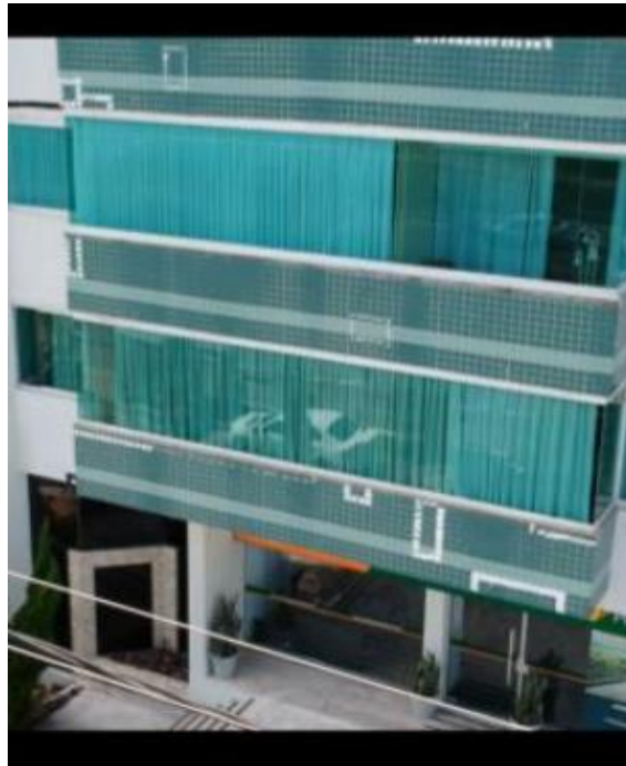
Figura 40- Registro através de drone na inspeção da fachada Norte
