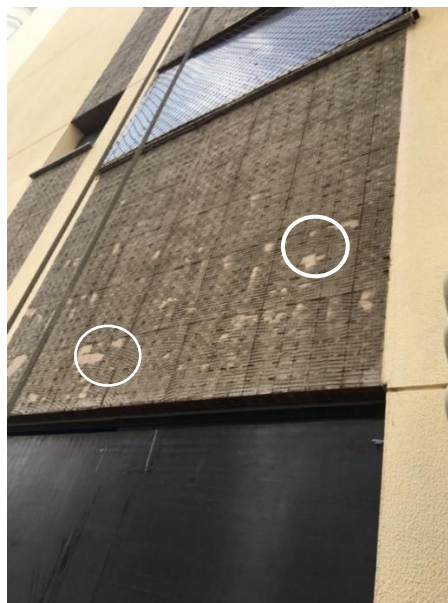
Figura 26- Emboço aparente
