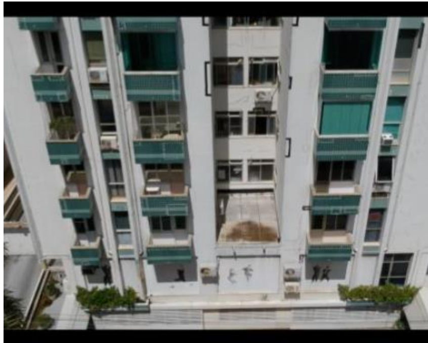
Figura 42- Registro através de drone na inspeção da fachada Leste
