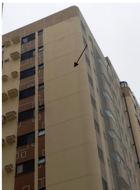
Figura 22- Junta de movimentação
