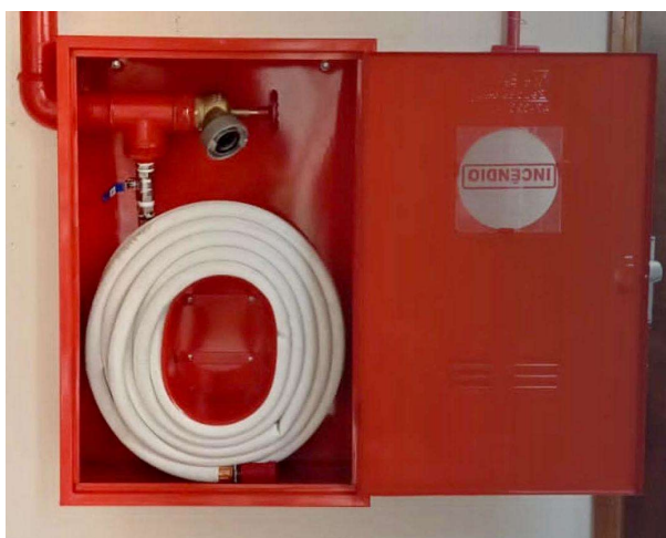
Figura 8 – Mangotinho em carretel móvel
