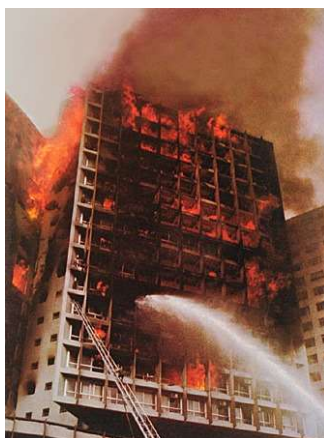
Figura 3 – Incêndio edifício Joelma
