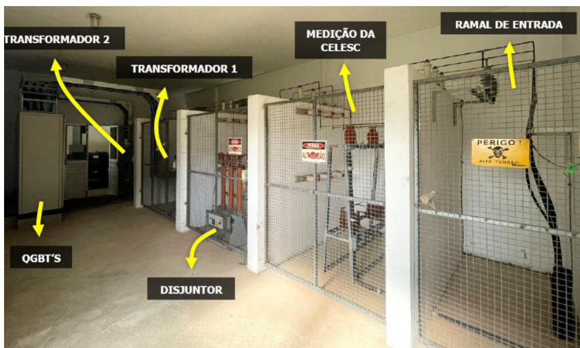
Figura 21 – Disposição da Subestação
