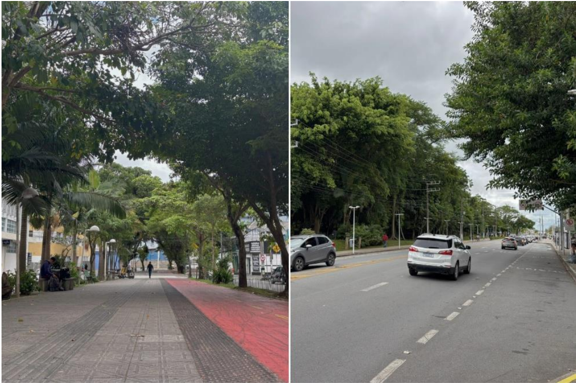
Figura 44 – Boulevard da Avenida Hercílio Luz e Parque da Luz – Trechos T4 e T8, respectivamente.
