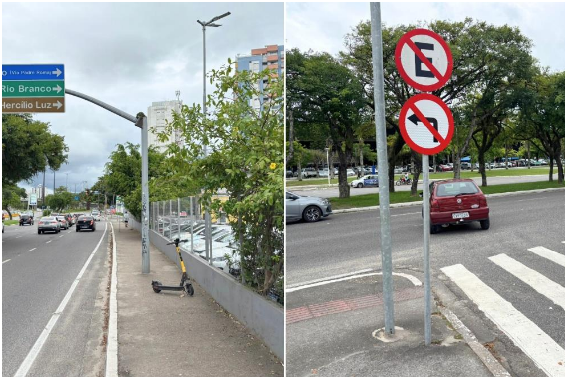
Figura 35 – Postes e placas comprometem a largura útil das calçadas – Trecho T10
