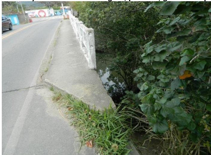
Figura 105 – Demonstração da faixa de rodagem, passeio, guarda corpo e acesso lateral
