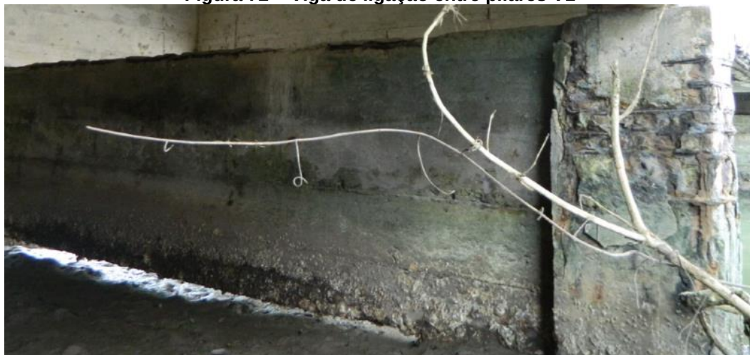
Figura 72 – Viga de ligação entre pilares V1
