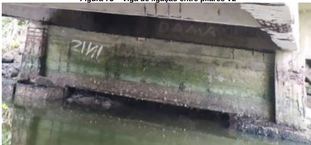
Figura 73 – Viga de ligação entre pilares V2
