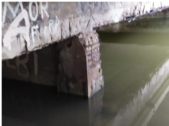
Figura 56 – Pilar imerso com dificuldade de aproximação e verificação de bloco de fundação.
