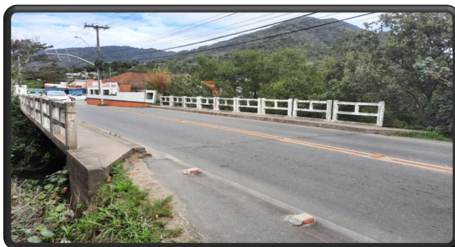
Figura 47 – Visualização da ponte do Ribeirão da Ilha
