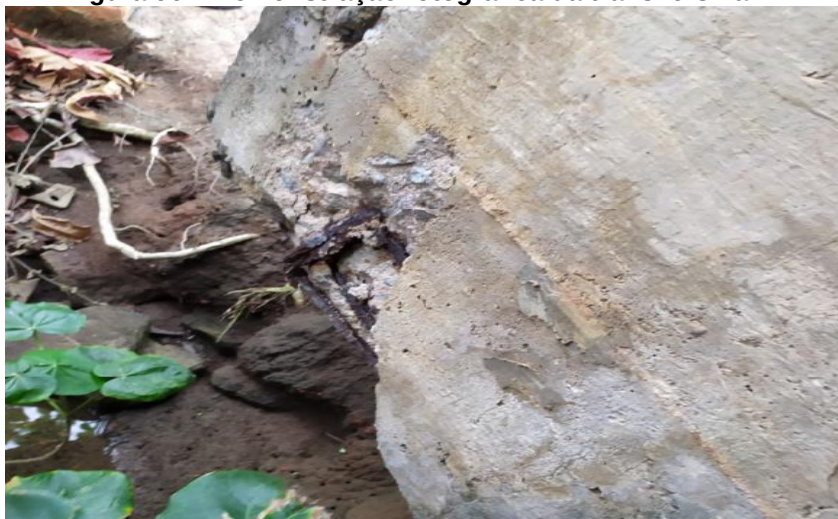
Figura 96 – Demonstração fotográfica da transversina T1
