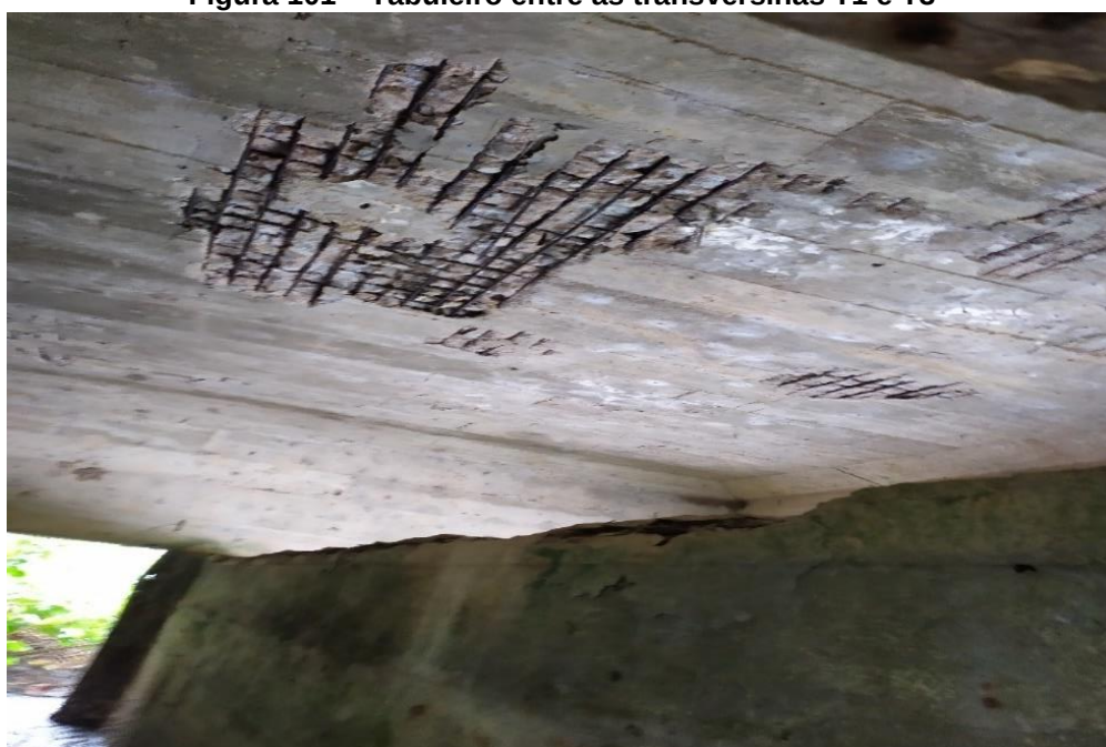
Figura 101 – Tabuleiro entre as transversinas T1 e T3
