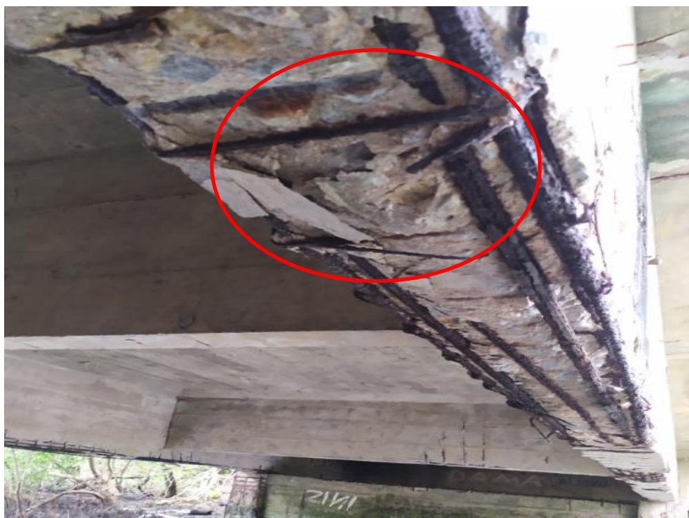
Figura 83 – Exposição e corrosão da armadura da longarina L1
