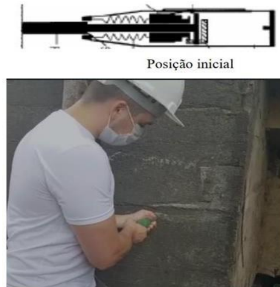
Figura 60 – Contato do esclerômetro com a superfície de concreto (a)
