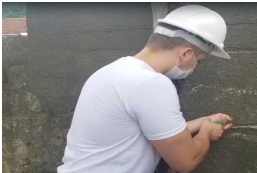
Figura 58 – Realização do ensaio não destrutivo com esclerômetro
