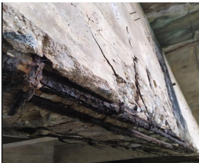
Figura 83 – Exposição e corrosão da armadura da longarina L1
