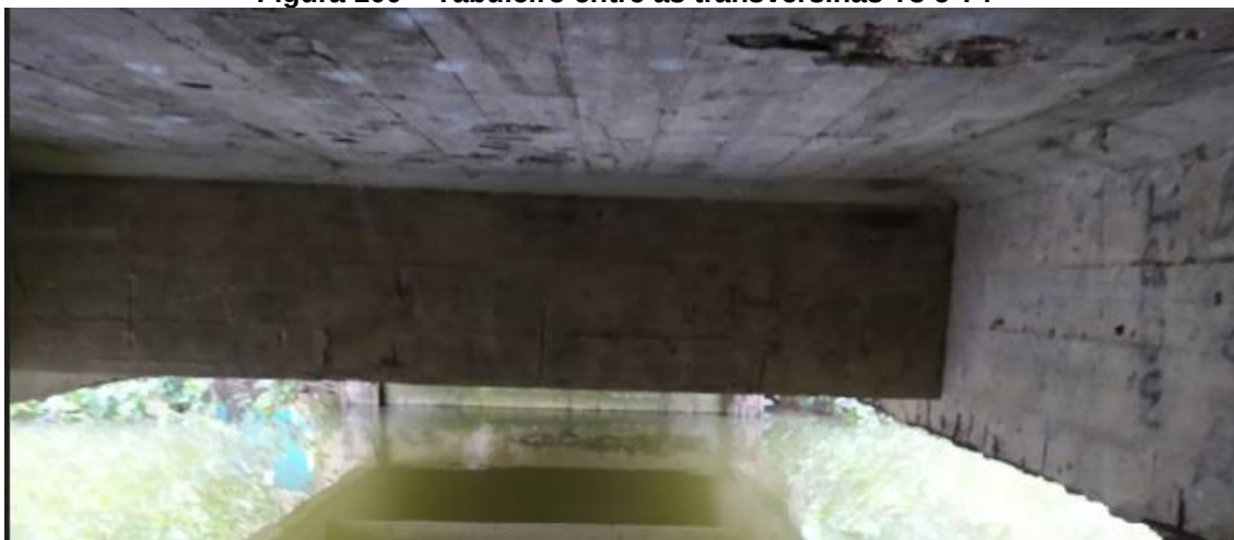
Figura 100 – Tabuleiro entre as transversinas T3 e T4
