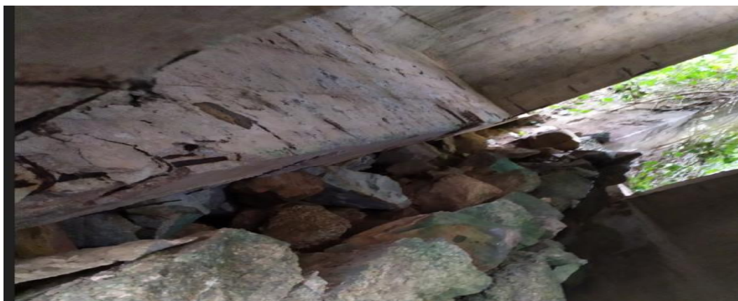
Figura 91 – Demonstração fotográfica da transversina T4
