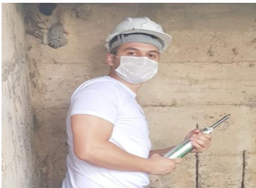
Figura 57 – Escolha de um dos locais para ensaio esclerometrico
