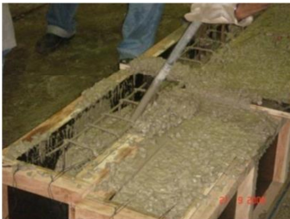
Figura 12 – Preenchimento da fôrma com concreto.
