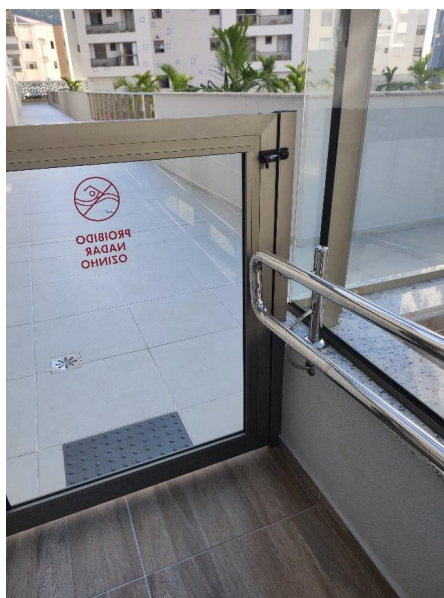
Figura 26 – Portão de acesso à piscina
