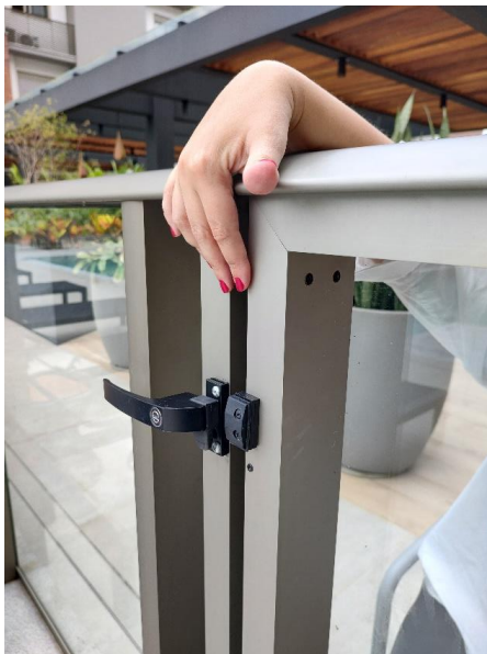
Figura 19 – Portão de acesso para a piscina
