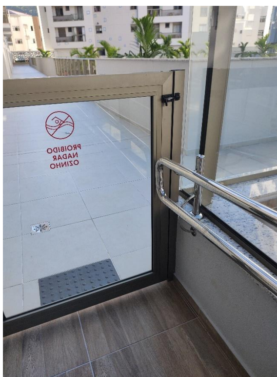
Figura 44 – Portão de acesso à piscina
