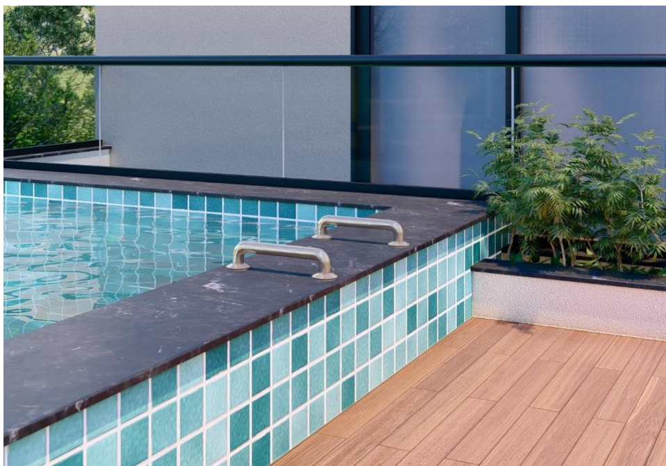
Figura 2 – Piscina com banco de transferência conforme NBR 9050:2015
