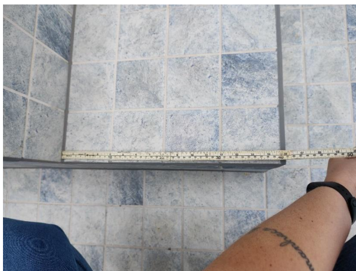
Figura 28 – Piso do Degrau
