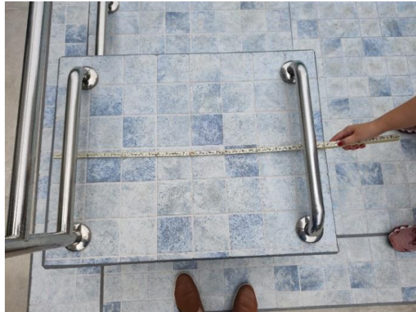
Figura 31 – Largura da escada com degrau submerso
