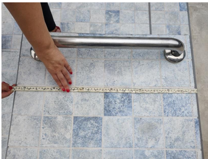
Figura 29 – Piso da Plataforma
