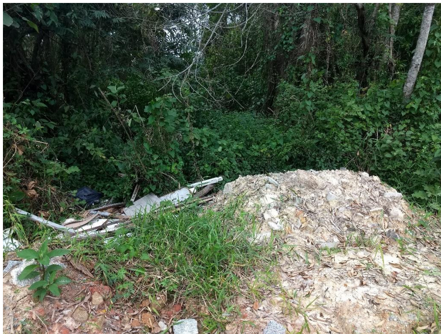
Figura 34 – Ponto 15 de disposição irregular
