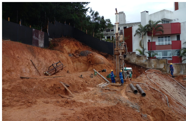
Figura 26 – Execução das estacas raiz
