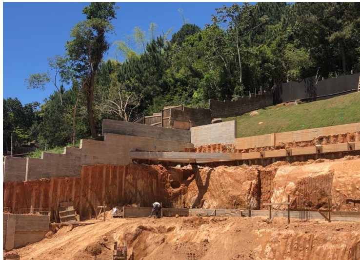
Figura 36 - Execução da estronca e tirantes
