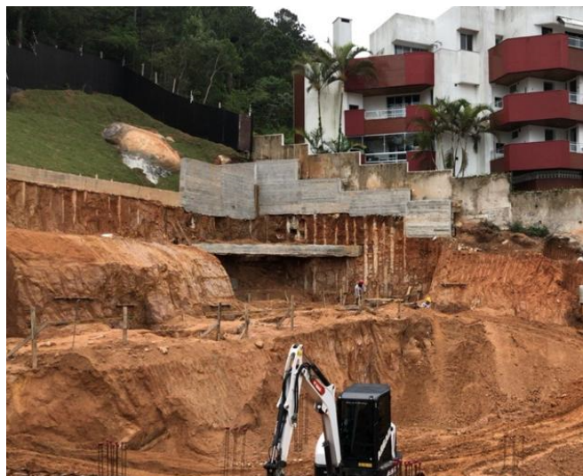
Figura 41 - Execução estronca – Lateral direita
