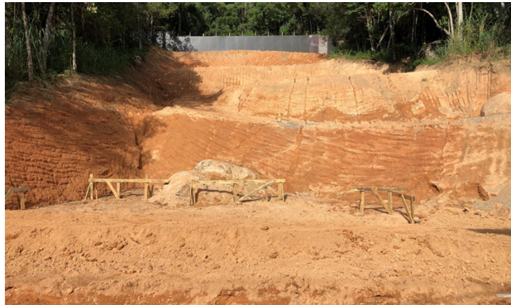
Figura 25 – Execução taludes
