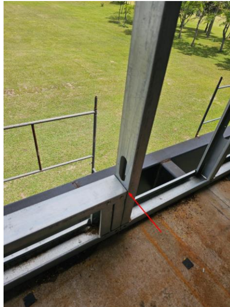
Figura 13 - Vão com a estrutura do Steel Frame aparente
