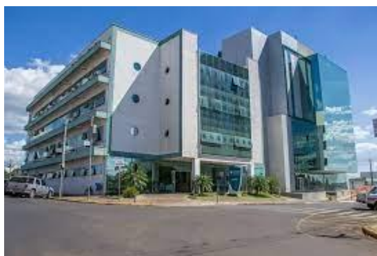
Imagem 01 – Hospital Regional São Paulo na cidade de Xanxerê/SC
