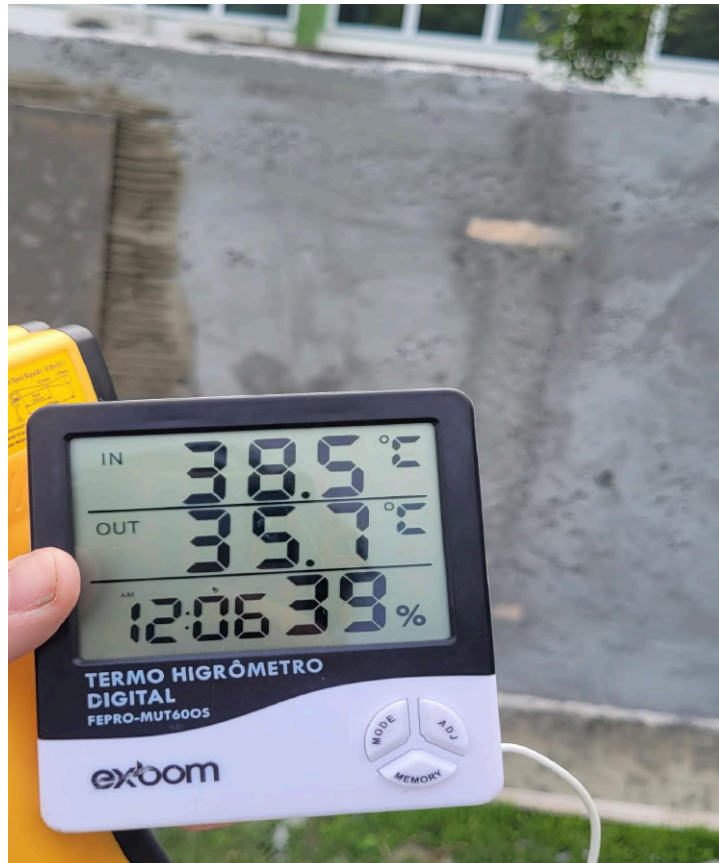
Imagem 3 - Temperatura Ambiente e umidade relativa do ar no dia do assentamento
