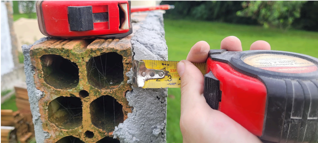
Imagem 7 - Espessura do Reboco
