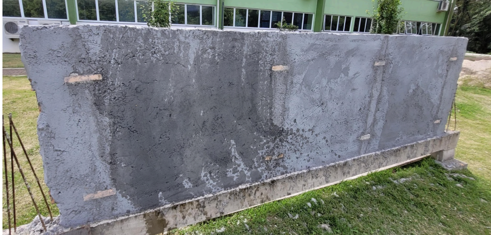
Imagem 1 - Parede umedecida e seca
