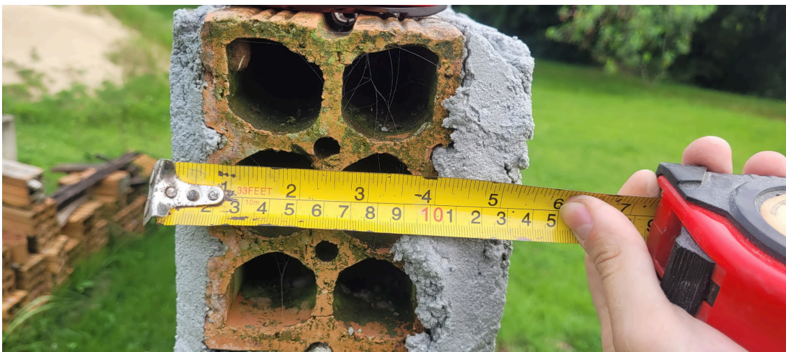
Imagem 8 - Espessura da Parede
