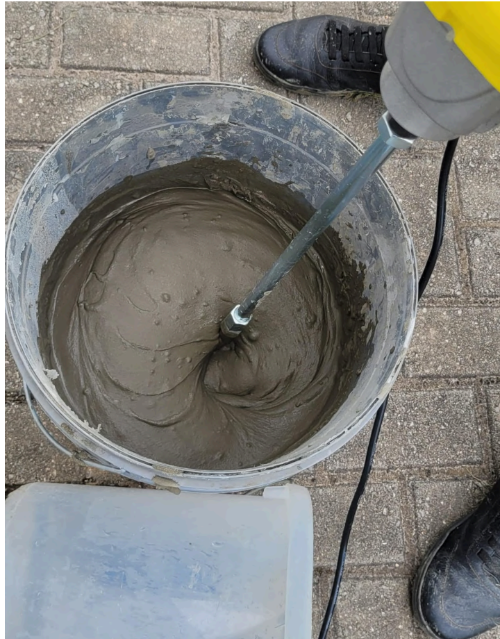
Imagem 6 - Mistura da Argamassa Colante
