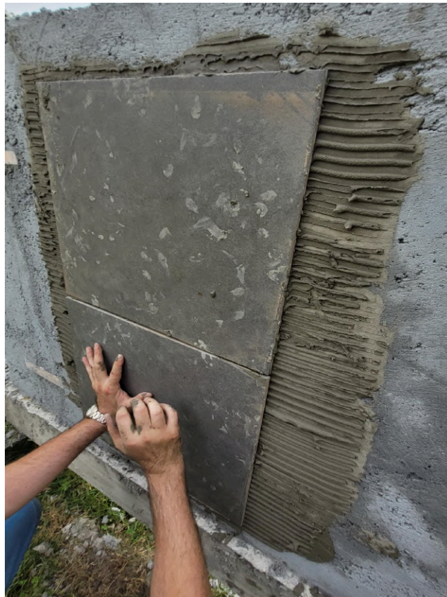
Imagem 2 - Assentamento das peças cerâmicas
