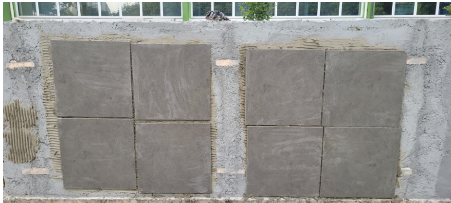
Imagem 5 - Peças cerâmicas no dia do assentamento
