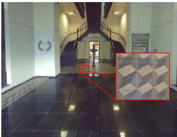
Figura 49 – Revestimento cerâmico da entrada da edificação
