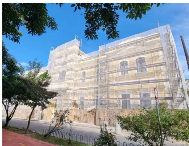
Figura 25 – Restauro na fachada em andamento
