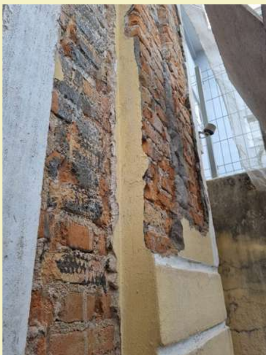
Figura 12 – Estrutura das paredes da edificação
