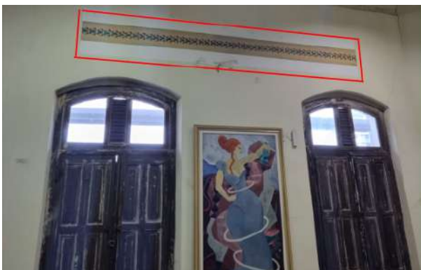
Figura 28 – Pinturas preservadas nas paredes
