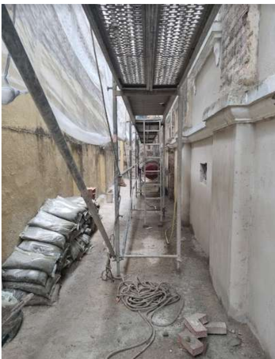
Figura 24 – Parte lateral do edifício em obra
