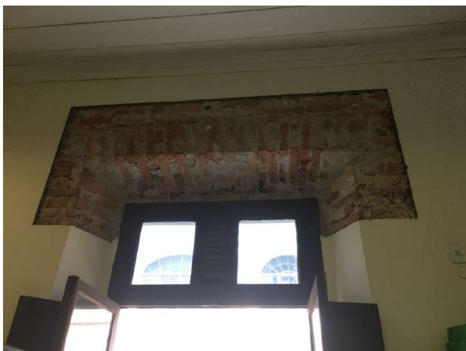
Figura 27 – Parte da estrutura aparente
