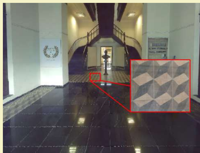
Figura 14 - Revestimento cerâmico da entrada da edificação
