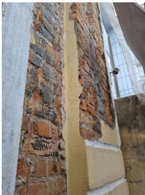
Figura 48 – Estrutura das paredes da edificação
