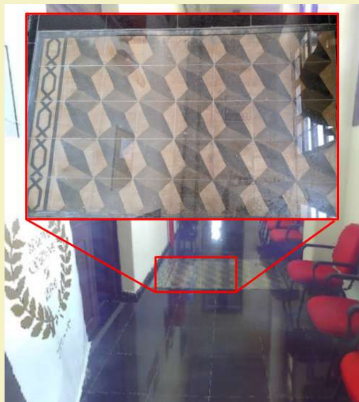
Figura 13 – Revestimento cerâmico com moldura em vidro no corredor da edificação
