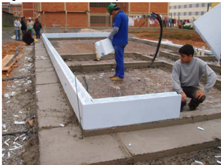
Figura 09 – Assentamento da primeira fiada de blocos ICF
