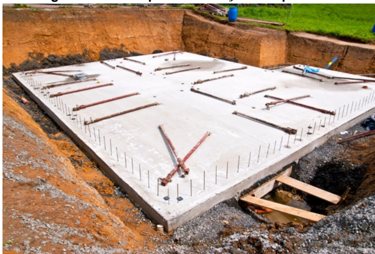
Figura 07 – Exemplo de fundação do tipo Radier
