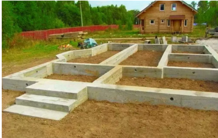
Figura 08 – Exemplo de fundação do tipo sapata corrida
