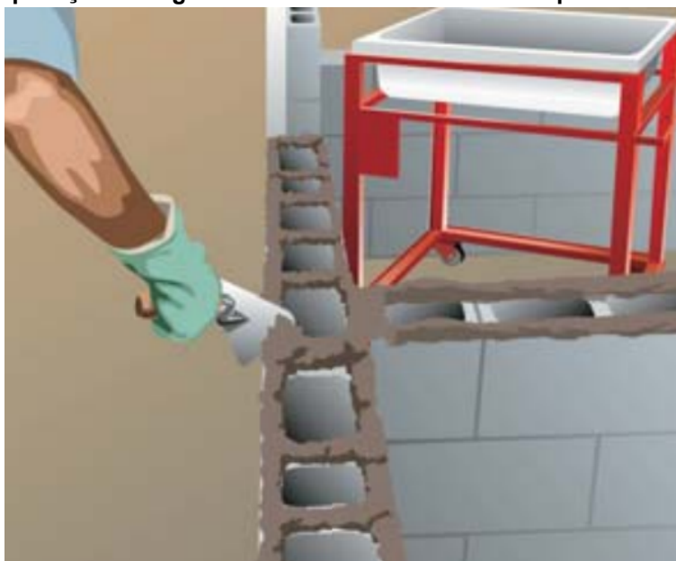
Figura 04a - Aplicação de argamassa nos blocos de concreto para alvenaria estrutural
