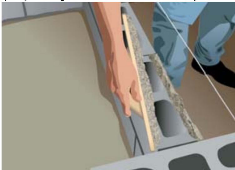
Figura 04b - Aplicação de argamassa nos blocos de concreto para alvenaria estrutural
