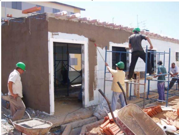
Figura 10 – Procedimento de chapisco rolado em alvenaria de ICF
