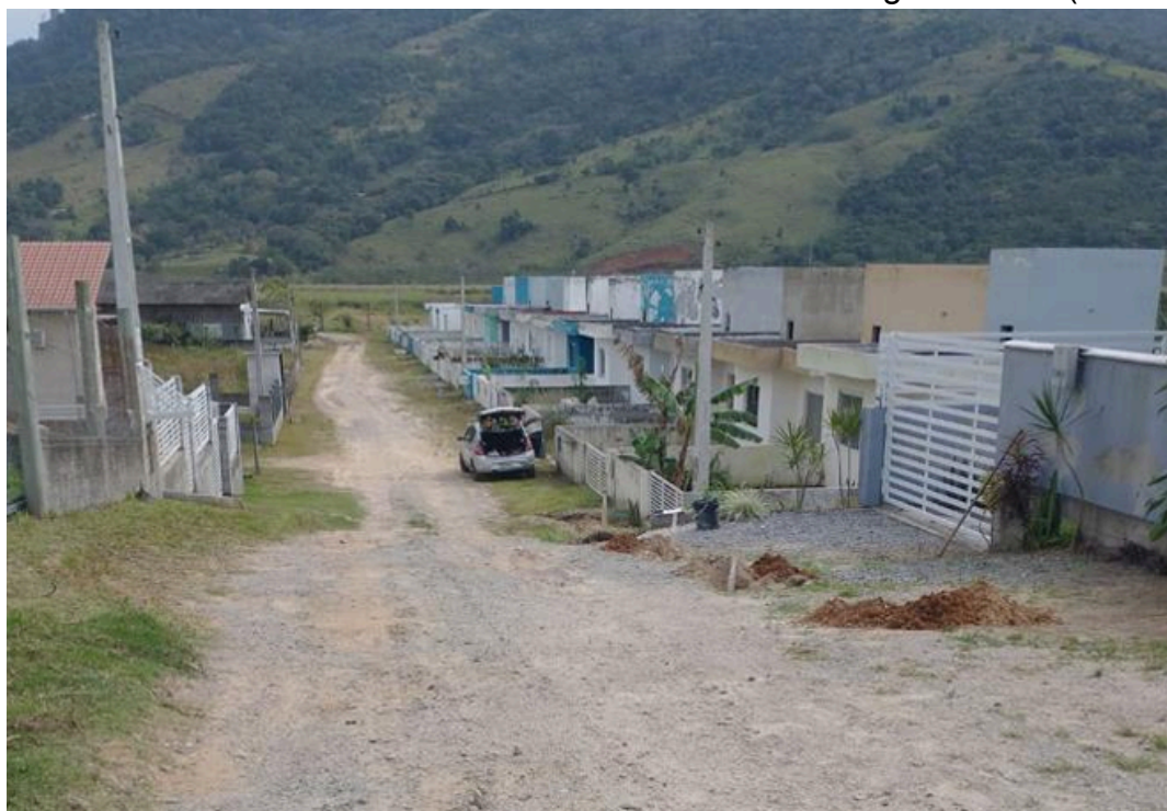
Figura 10: Núcleo “José Carlos” sem o fornecimento de Energia Elétrica.(Abril/2024)
