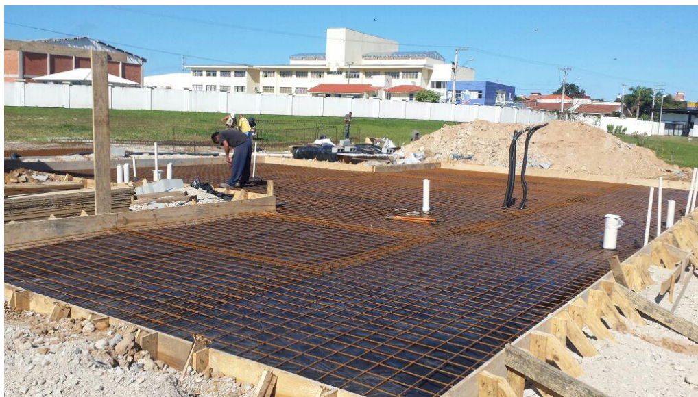
Figura 27 - Execução do Radier
