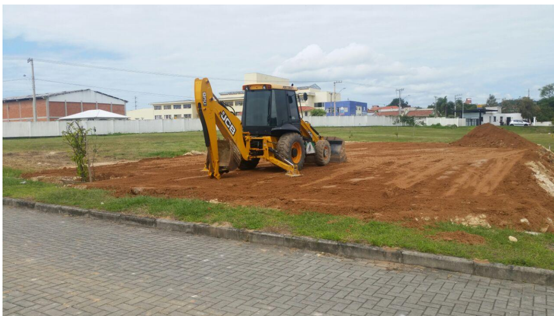
Figura 25 - Regularização do Terreno
