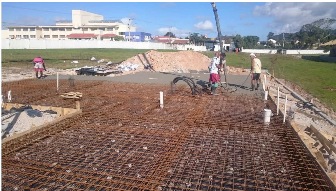
Figura 28 - Concretagem Radier
