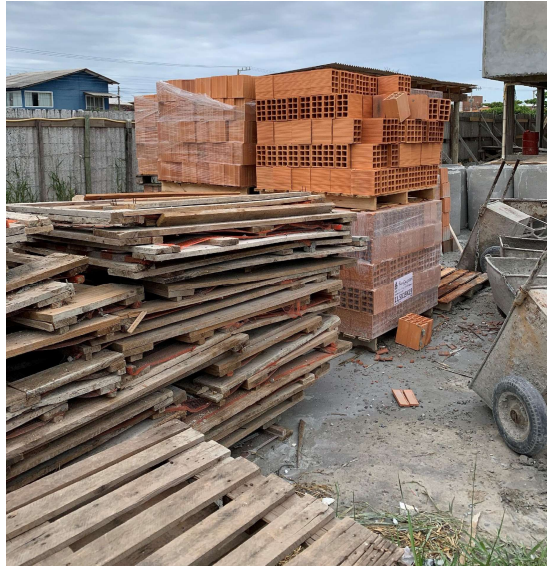
Figura 11: Local de estoque dos blocos cerâmicos.
