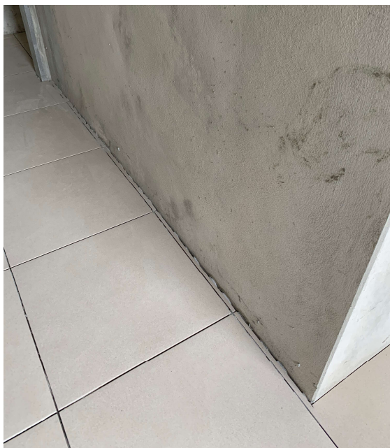
Figura 18: Paginação dos pisos cerâmicos.
