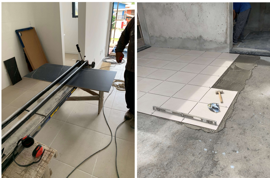
Figura 17: Ferramentas e equipamentos para revestimentos cerâmicos.
