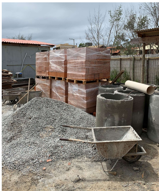
Figura 12: Local de estoque dos blocos cerâmicos.
