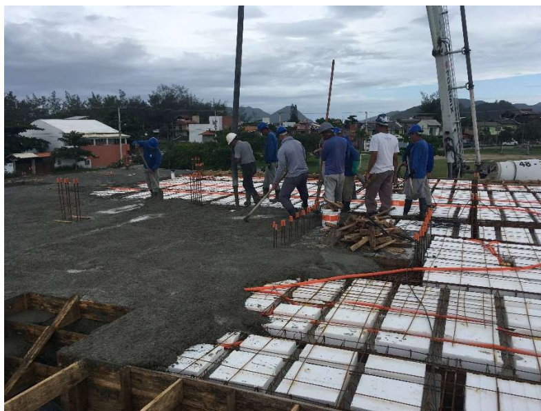
Figura 13: Funcionários da construtora no lançamento do concreto.
