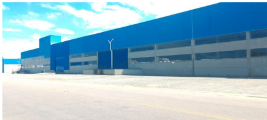
Figura 10 - Galpão Industrial em São José (SC)
