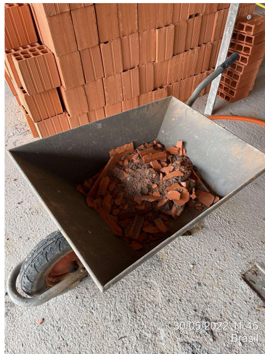
Figura 26 - Transporte de resíduos
