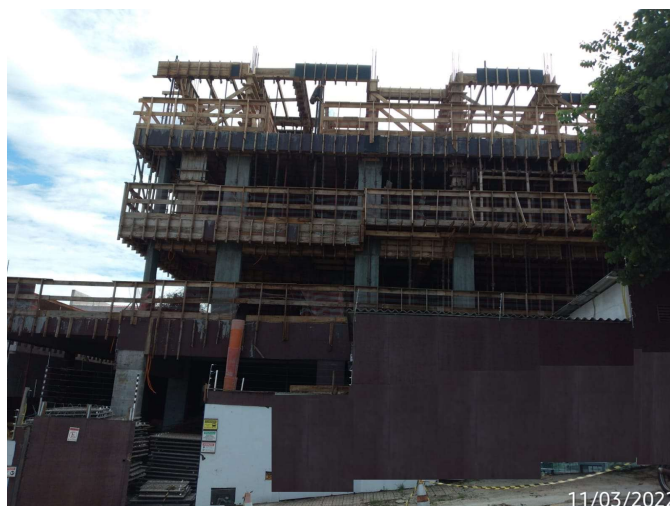
Figura 7 - Fachada da obra no início do levantamento de dados da pesquisa
