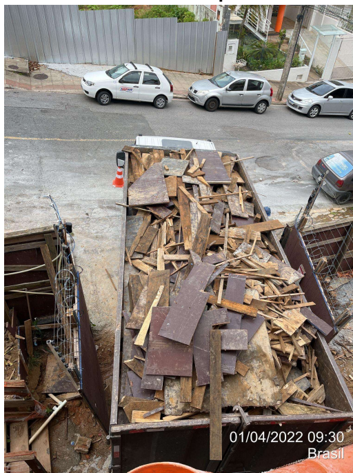
Figura 14 - Retirada de madeira por caminhão caçamba
