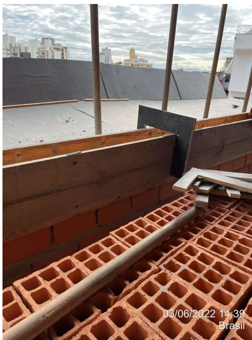
Figura 35 - Contraverga da janela
