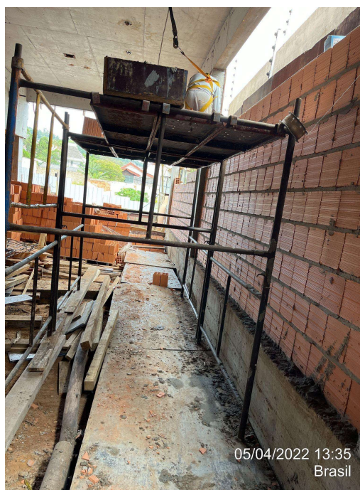
Figura 15 - Alvenaria perimetral
