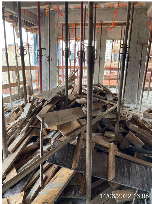
Figura 38 - Resíduos da desforma do pavimento tipo 2
