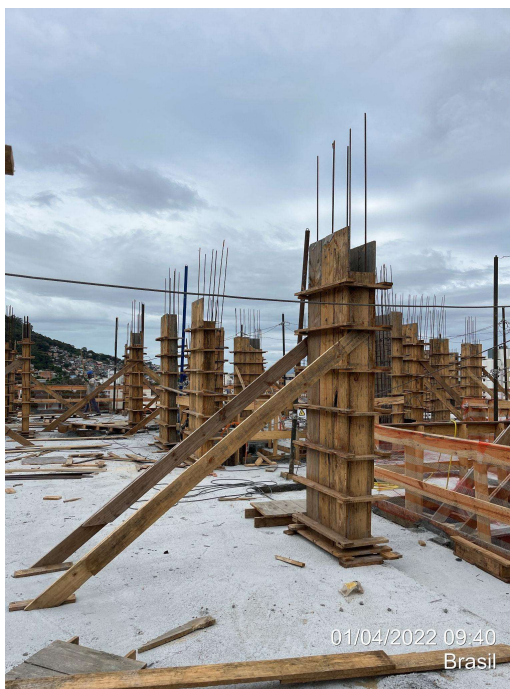
Figura 21 - Montagem e travamento dos pilares do pavimento Tipo 2
