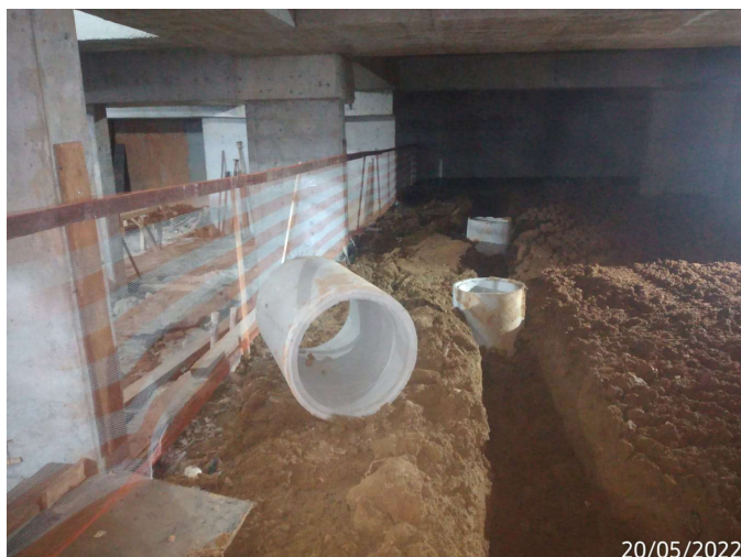
Figura 24 - Drenagem do subsolo
