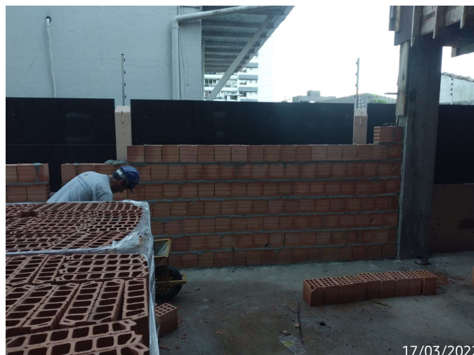
Figura 10 - Execução da alvenaria perimetral no pavimento térreo
