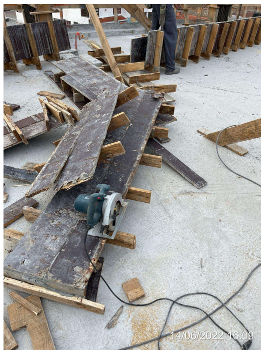
Figura 41 - Etapa de fôrma dos pilares e vigas do pavimento tipo 4
