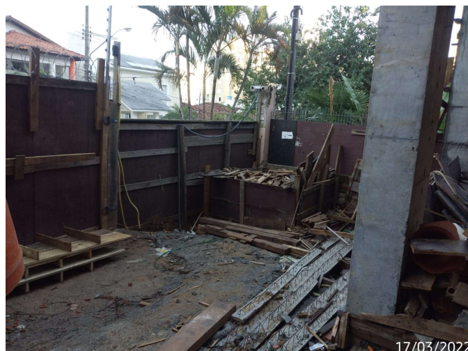
Figura 8 - Baia de madeira no pavimento subsolo
