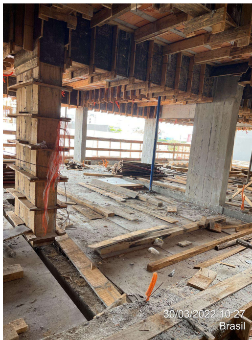
Figura 19 - Desforma dos pilares do pavimento Tipo 1
