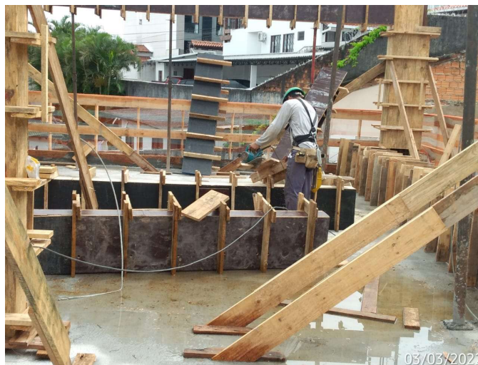
Figura 12 - Execução de fôrmas de pilares e vigas do pavimento Tipo 1
