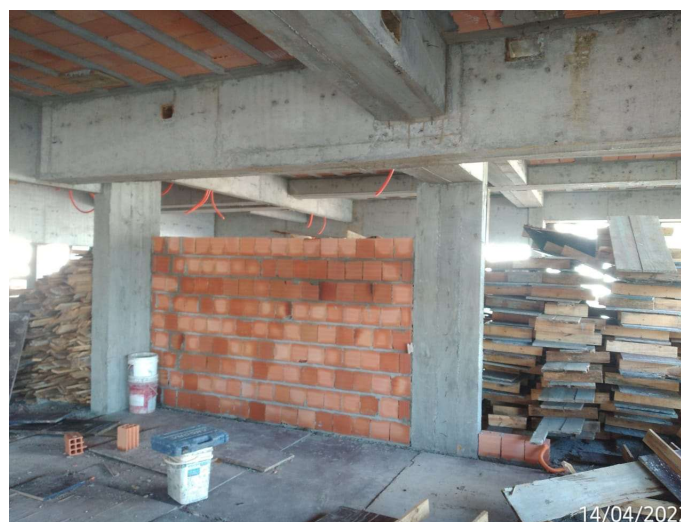
Figura 18 - Início da alvenaria interna do mezanino
