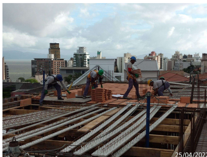
Figura 23 - Execução da laje do teto do tipo 2
