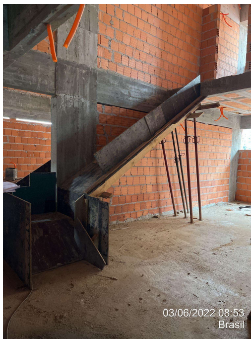
Figura 33 - Fôrmas das escadas dos lofts no térreo e mezanino
