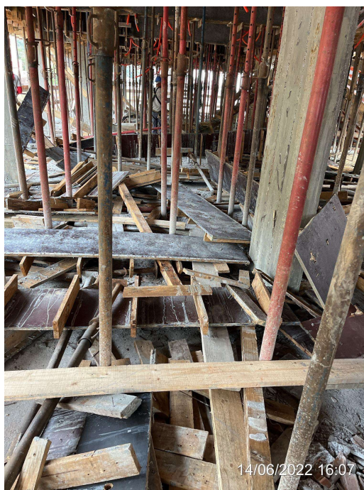
Figura 40 - Desforma do pavimento tipo 3
