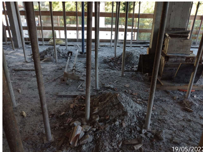
Figura 31 - Resíduos de concreto e madeira provenientes das desformas
