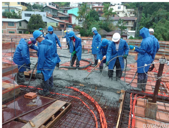
Figura 39 - Concretagem da laje do teto do pavimento tipo 3
