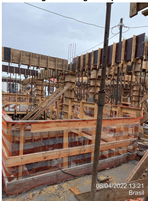
Figura 22 - Montagem das vigas do pavimento Tipo 2
