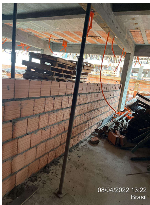
Figura 16 - Realização da alvenaria do pavimento Térreo
