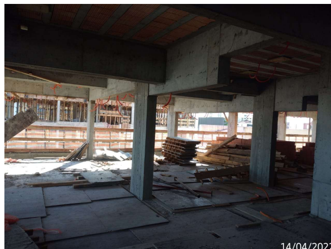
Figura 17 - Desforma do teto do Mezanino
