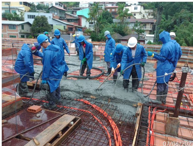
Figura 45 - Concretagem de laje
