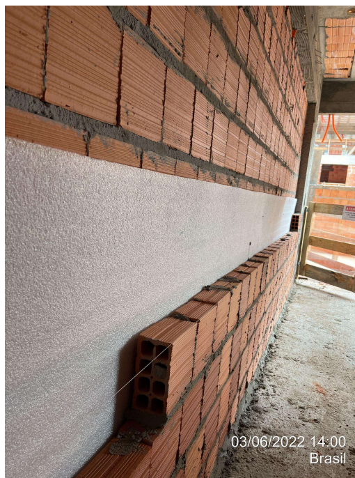
Figura 34 - Colocação de manta acústica em parede dupla
