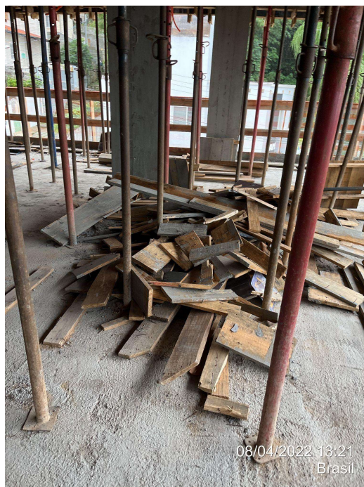
Figura 20 - Desforma das vigas do pavimento Tipo 1
