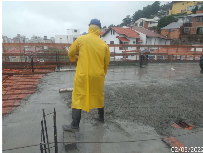
Figura 30 - Concretagem do teto do pavimento Tipo 2
