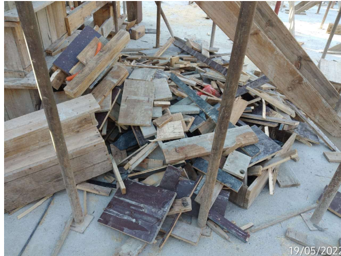
Figura 43 - Resíduos de madeira provenientes das fôrmas
