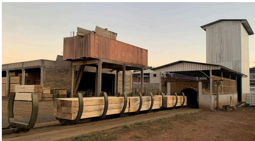
Figura 23 - Etapa de carregamento da autoclave.
