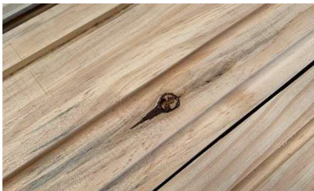
Figura 33 - Peça de pinus não conforme com presença de nós “careados”.
