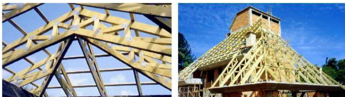
Figura 10 - Vista de tesouras de madeira em telhados residenciais
