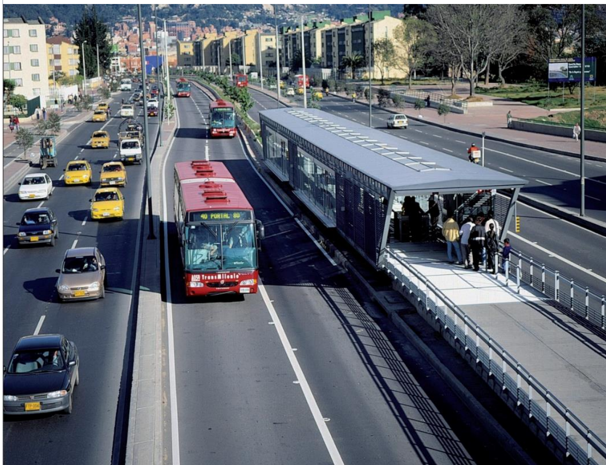
Figura 6 - Estação Transmilenio com vias segregadas e faixas de ultrapassagem
