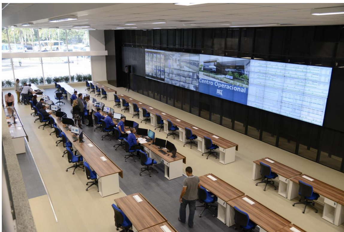
Figura 8 – Centro operacional do BRT no Rio de Janeiro
