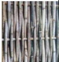
Figura 8 – Trama feita com ripas de bambu
