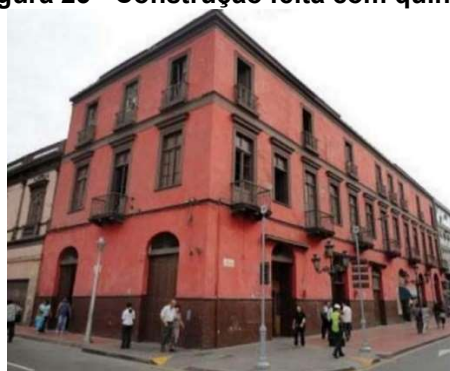
Figura 23 - Construção feita com quincha
