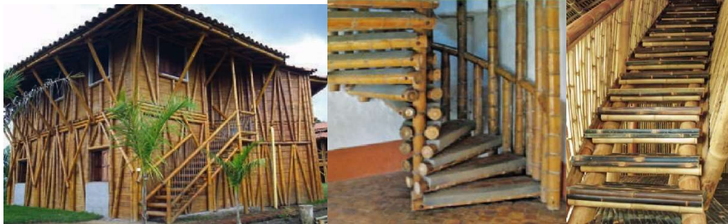
Figura 17 - Escadas em bambu
