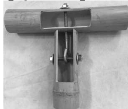
Figura 78 – Ligação com ganchos e parafusos
