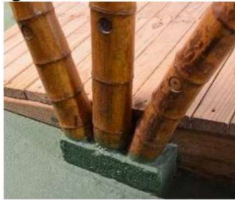
Figura 20 – Exemplo e detalhe de ancoragem de pilares em bambu à fundação de concreto
