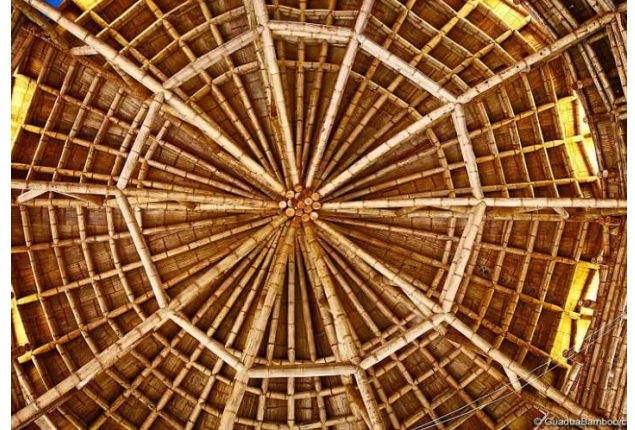
Figura 5 – Telhado com colmos de bambu
