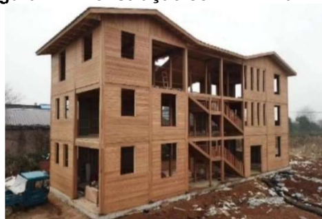
Figura 11 - Construção com BLC na China
