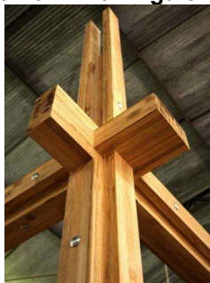
Figura 10 – Pilar-viga em BLC
