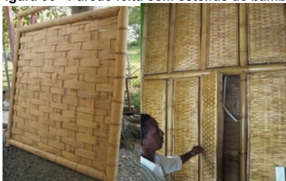
Figura 30 - Parede feita com esteiras de bambu
