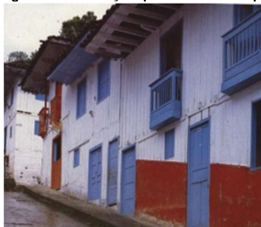
Figura 25 - Edificação que utiliza bahareque
