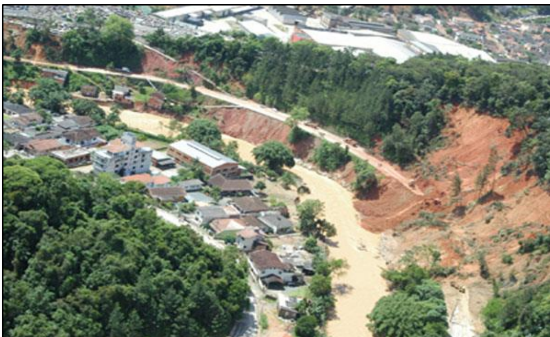
Figura 7 - Inundação e deslizamentos em Blumenau 2008.
