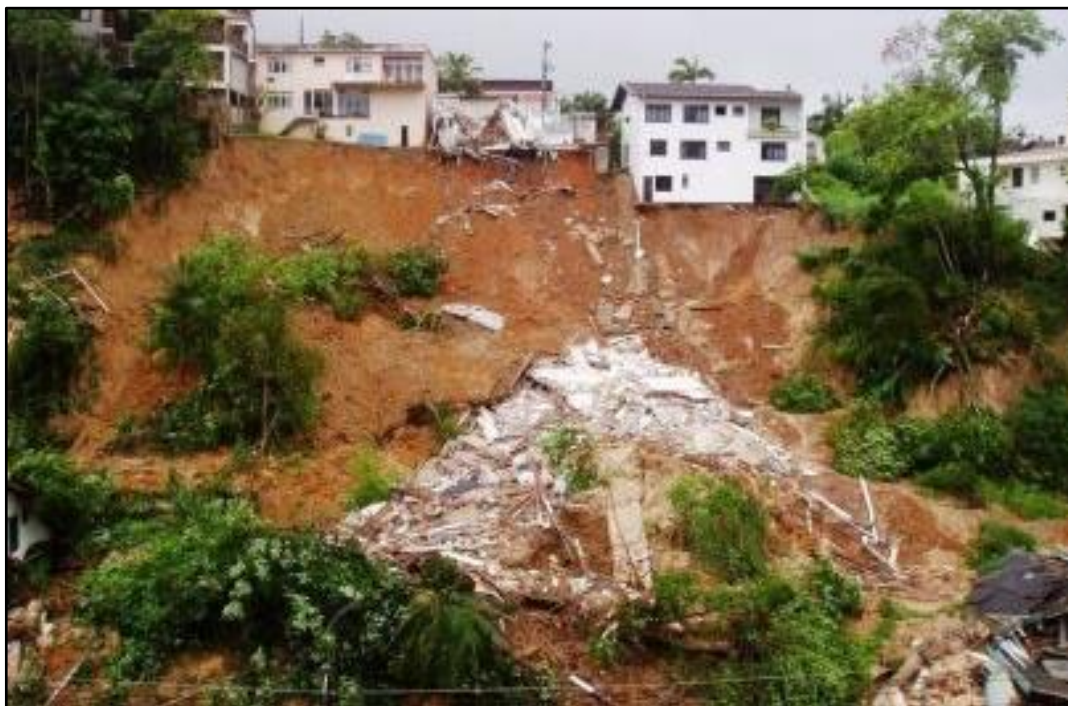
Figura 8 - Deslizamento de encosta, Blumenau 2008.
