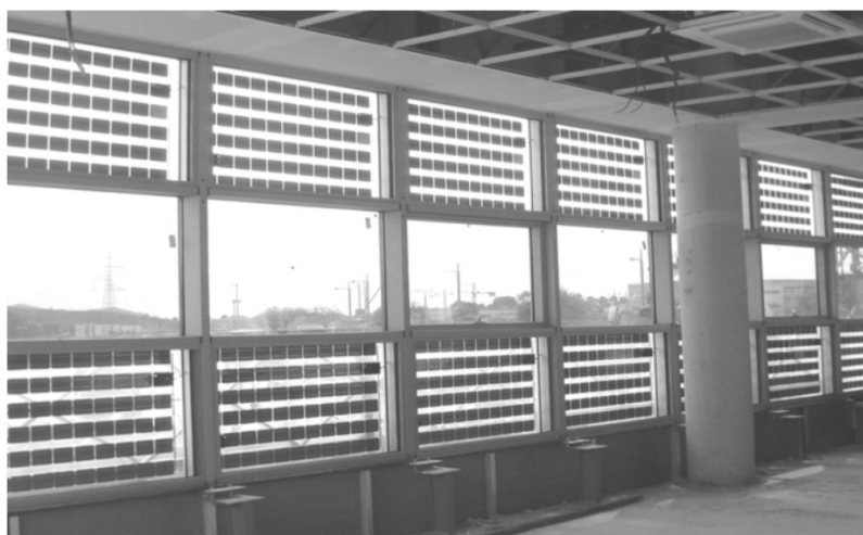
Figura 13 – Vista interna da parede-cortina no período de construção
