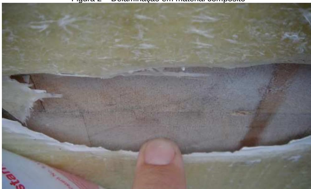
Figura 2 – Delaminação em material compósito
