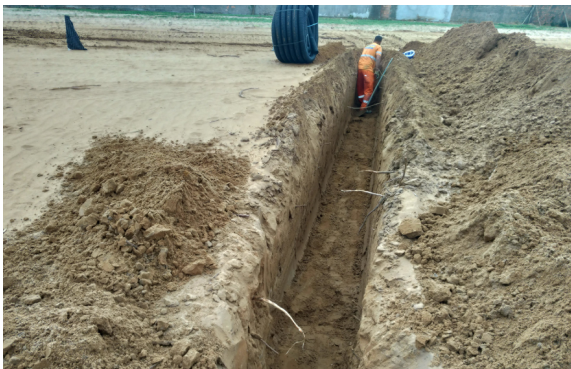
Figura 06 - Escavação e colocação da tubulação elétrica
