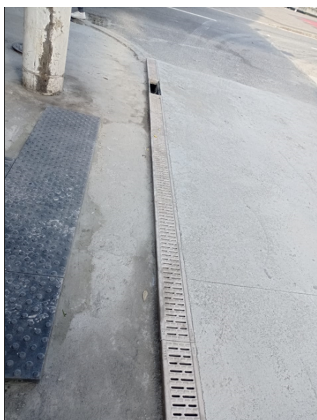
Figura 01 - Detalhe do ralo linear Implantado na via
