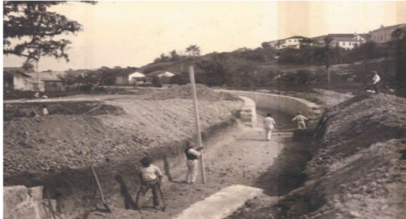
Figura 12: "Obra de Canalização do Rio da Bulha, 1919". Fonte: Acervo da Casa da Memória.
