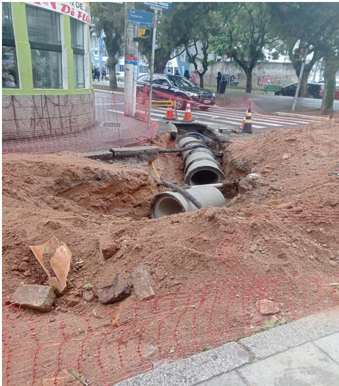
Figura 29 - Exemplo de tubulação de esgoto de 500 mm
