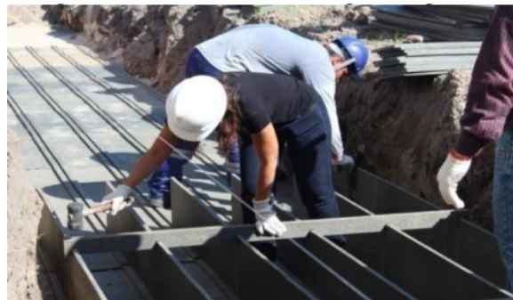
Figura 11 - Montagem do sistema de trava entre paredes plásticas.
