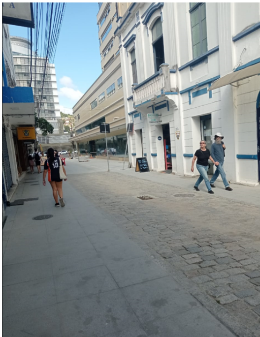
Figura 03 - Detalhe do paralelepípedo e pavimento usado na calçada
