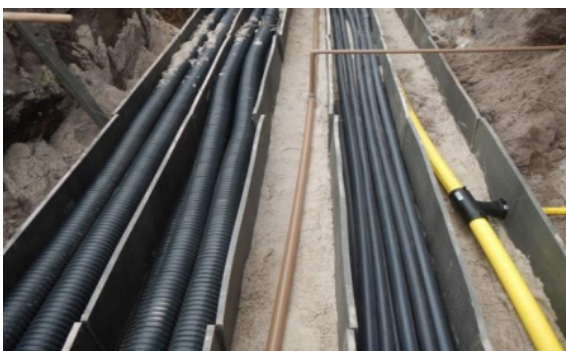
Figura 13 - Montagem das redes de infraestrutura nas baias.
