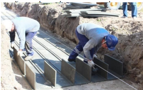
Figura 10 - Montagem dos painéis parede sobre base plástica
