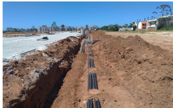
Figura 06 - Escavação e colocação da tubulação elétrica
