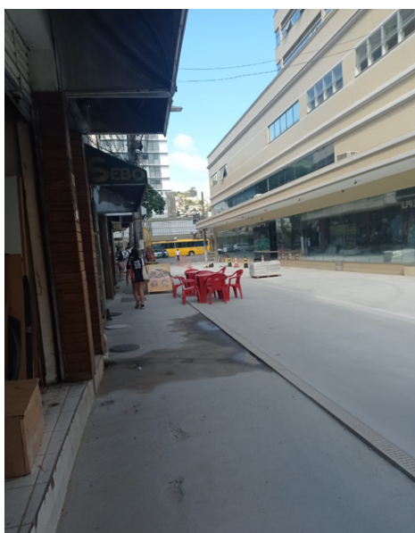
Figura 02 - Nivelamento da calçada com a via de rolamento
