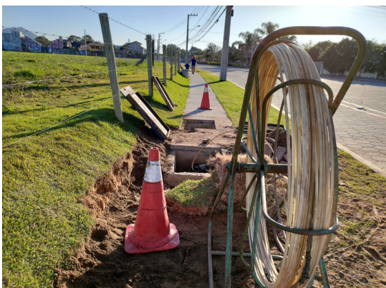
Figura 07 - Passagem da fiação elétrica e detalhamento do cabo enterrado
