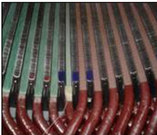
Figura 3: Acomodação do PT100 nas bobinas do motor Fonte: O autor (2022)
