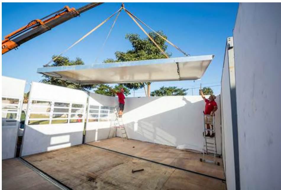
Figura 5 - Sistema de pisos painelizados (2D)
