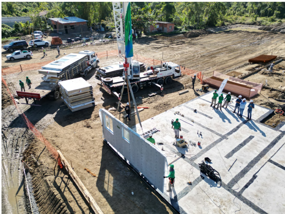
Figura 4 - Sistema de paredes painelizados (2D)
