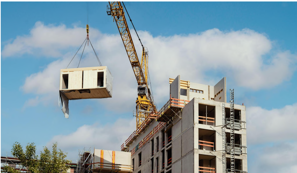
Figura 7 - Sistema Volumétrico (3D) sendo içado para montagem
