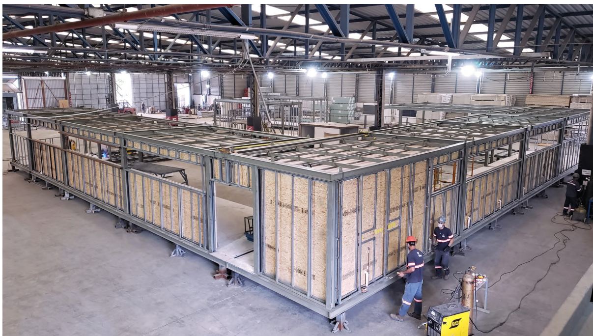
Figura 8 - Produção dos módulos do Hospital Vila Santa Catarina
