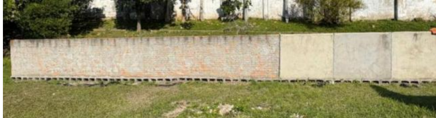
Figura 1 - Parede de alvenaria.
