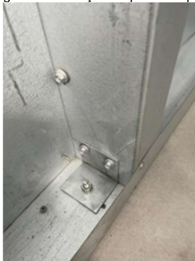
Figura 13 - Fixação da parede e piso
