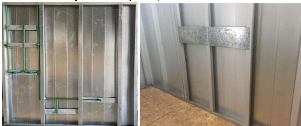
Figura 20 – Reforços das paredes de Steel Panel
