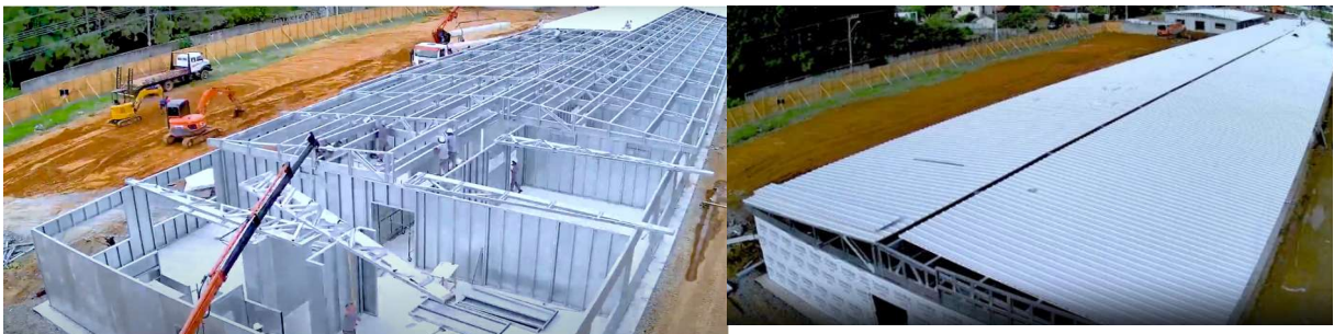
Figura 18 – a) Execução da estrutura da cobertura e b) Fechamento da cobertura
