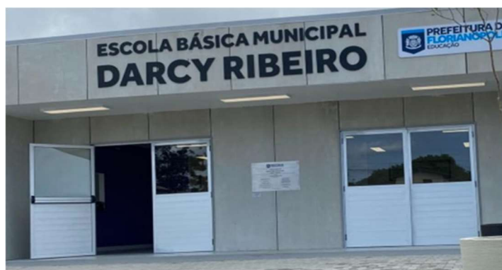
Figura 21 – Esquadrias de Alumínio da Entrada da Escola
