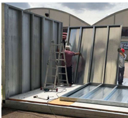
Figura 14 – a) Montagem das paredes da escola e b) Fixação entre módulos
