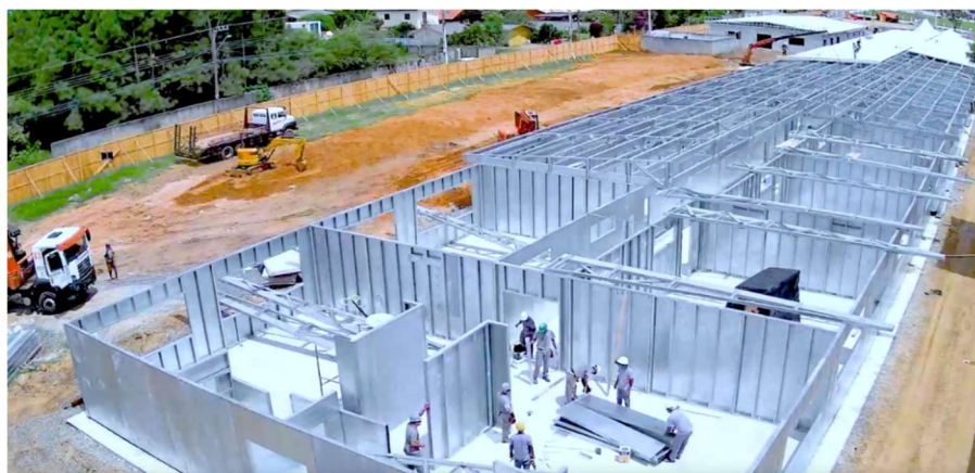
Figura 15 –Escola Municipal Darcy Ribeiro em construção
