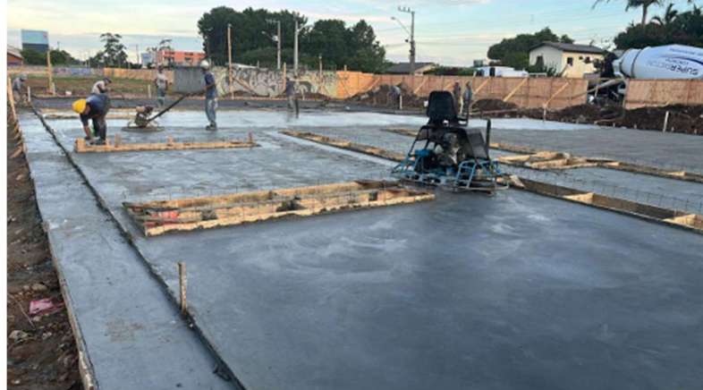
Figura 10 – Execução da Laje de Radier
