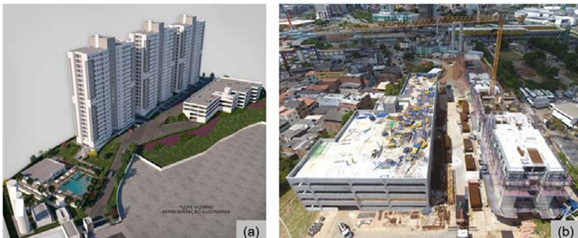
Figura 03 — Controle de obras: (a) projeto da edificação; (b) Canteiro em execução.
