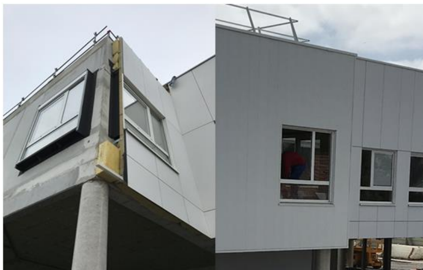
Figura 48 – Antes e depois da instalação da fachada em uma janela projetada
