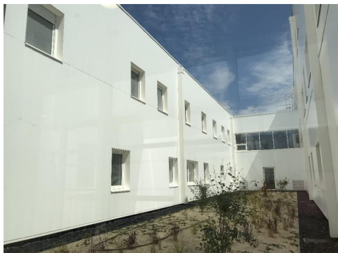
Figura 52 – Pátio Interior da Maternidade com a fachada ventilada finalizada
