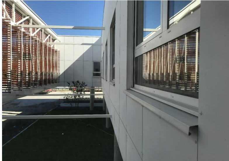
Figura 19 – Fachada ventilada com revestimento externo em fibrocimento
