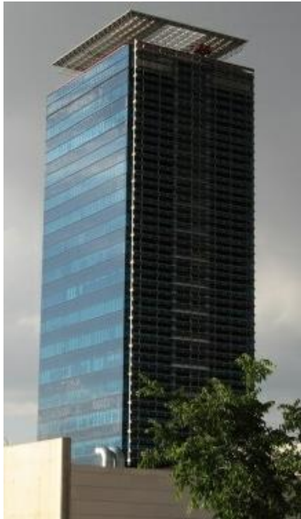
Figura 15 – Fachada ventilada com revestimento externo em painéis fotovoltaicos
