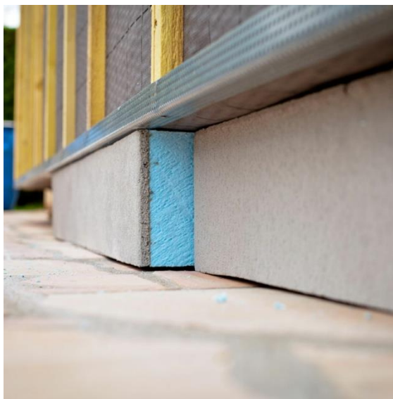
Figura 36 – Pannel de espuma de poliestireno azul com 10mm de argamassa
