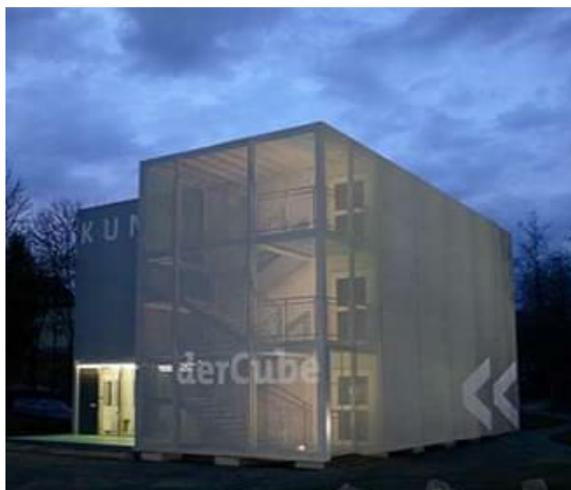
Figura 13 – Fachada ventilada com revestimento externo têxtil
