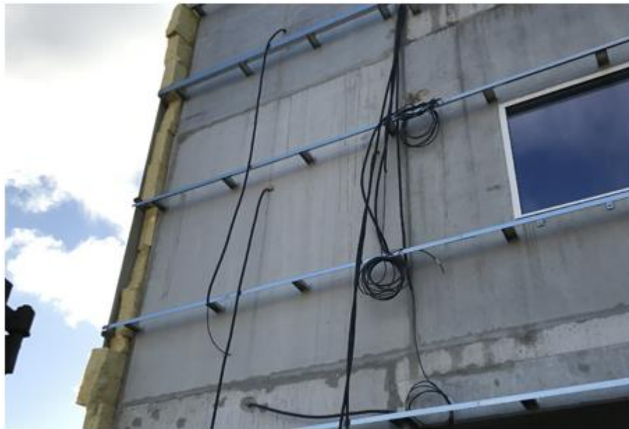
Figura 7 – Sistema de fachada ventilada com suportes em ACM
