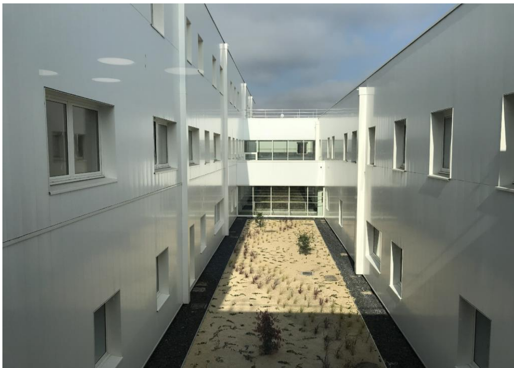
Figura 11 – Fachada ventilada com revestimento externo em ACM
