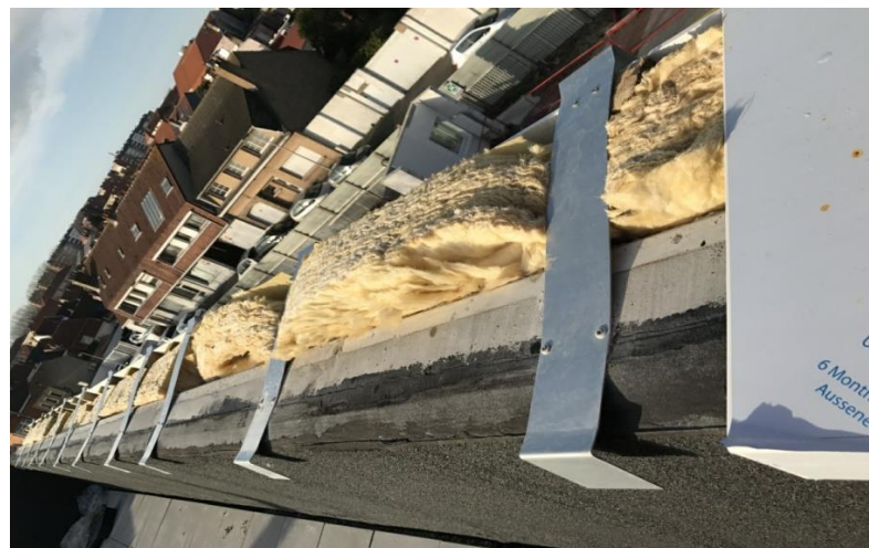
Figura 39 – Instalação do acabamento no nível do terraço da fachada ventilada
