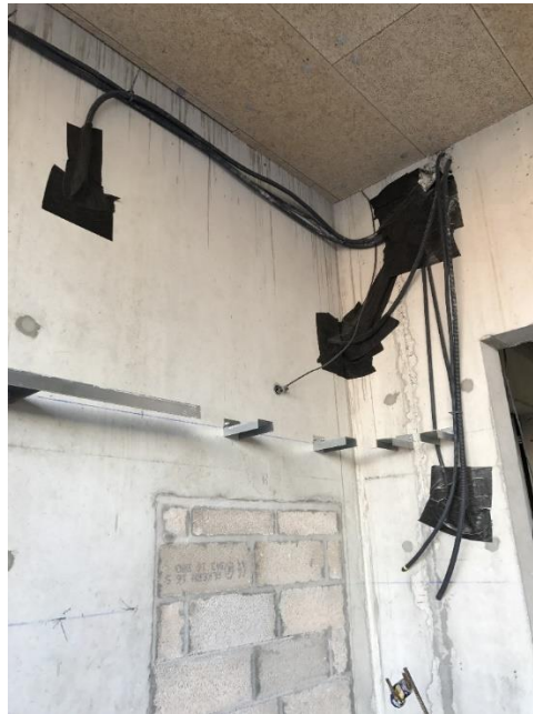
Figura 49 – Tratamento impermeabilizante com adesivos nas cordoalhas
