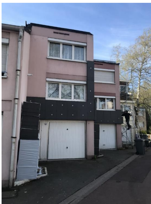
Figura 29 – Reabilitação de casas em Villeneuve d’Ascq na França
