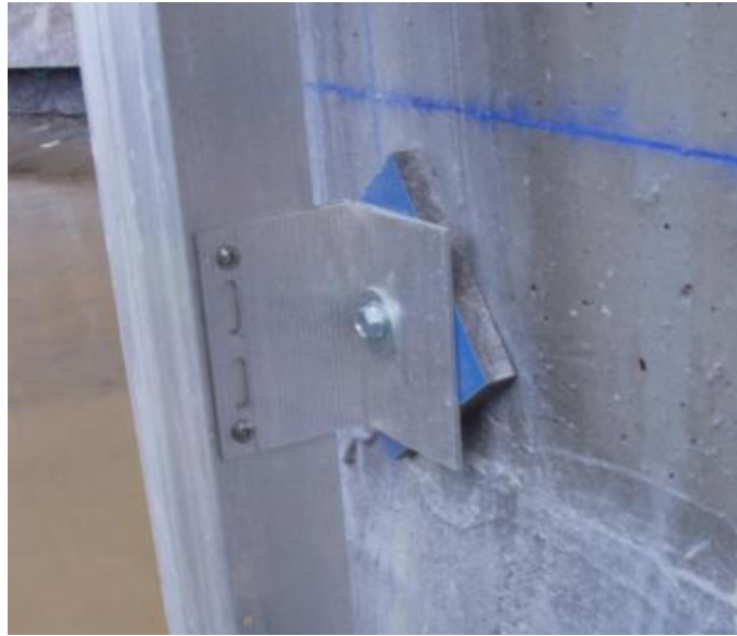
Figura 27 – Utilização de “calços” na afinação do prumo dos perfis
