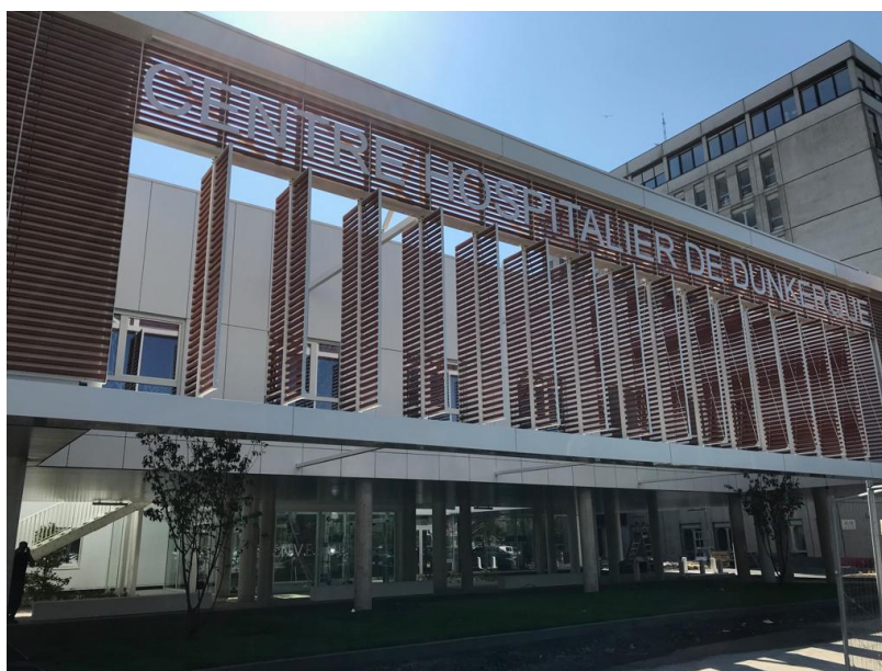
Figura 45 – Fachada da Maternidade do Centro Hospitalar de Dunquerque
