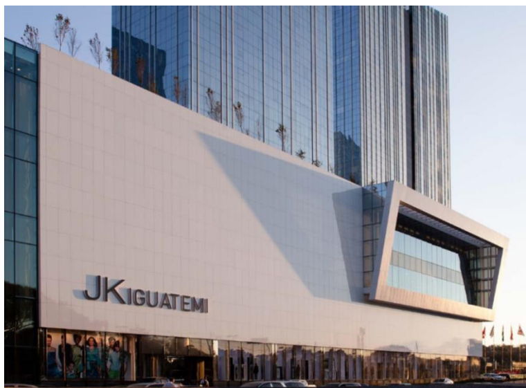
Figura 14 – Fachada ventilada com revestimento externo em cerâmica
