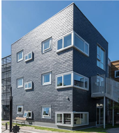
Figura 17 – Fachada ventilada com revestimento externo em ardósia
