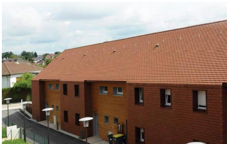
Figura 18 – Fachada ventilada com revestimento externo em terracota
